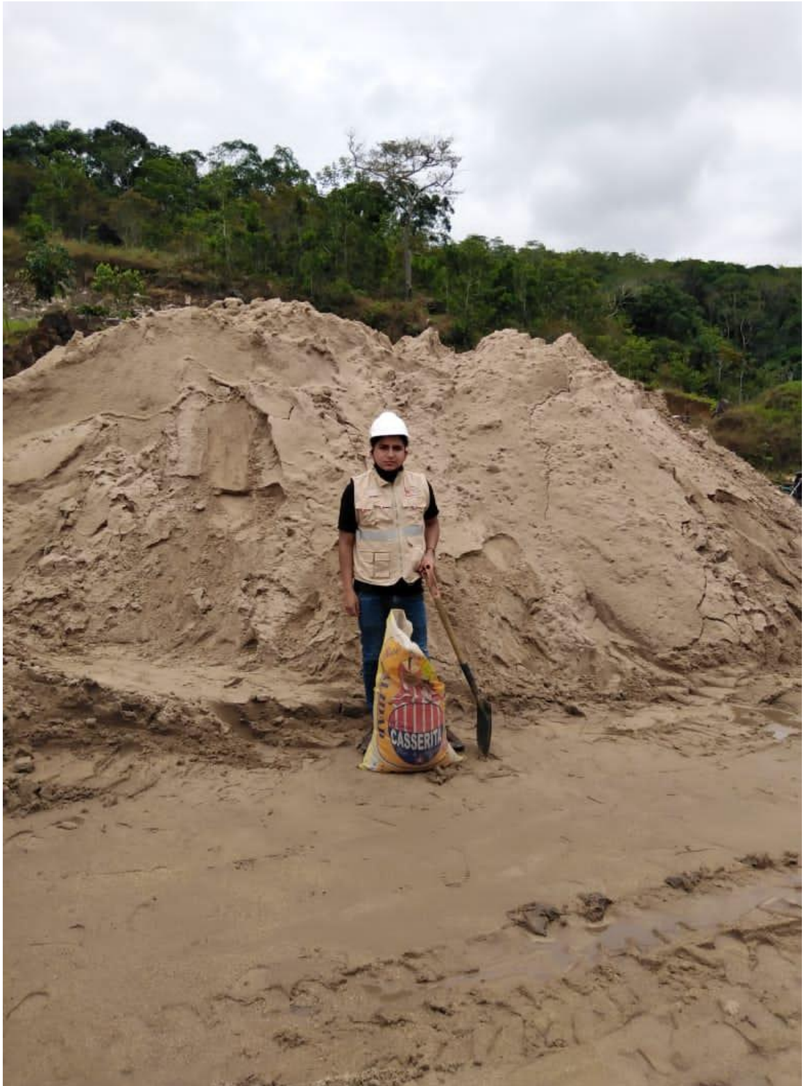
Figura N° 5. Extracción del agregado fino de la cantera “Futuro Indoche”
