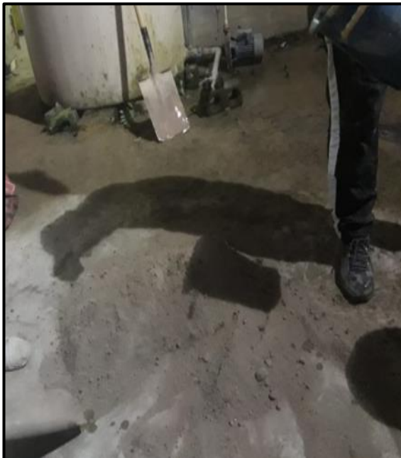
Fotografía N° 23: Evidencia del diseño de mezcla de la muestra patrón con el 0% de CCA para la elaboración de los ladrillos
