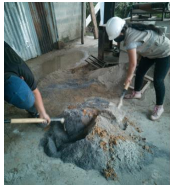
Fotografía N° 28: Mezcla de materiales, para la elaboración de los ladrillos.
