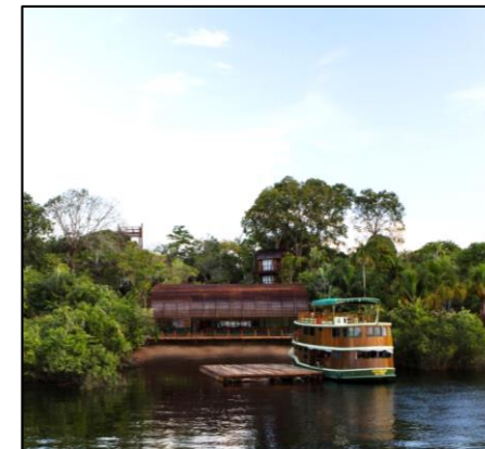
Vista externa Fuente: Archdaily
