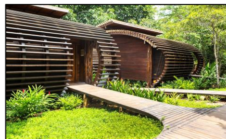
Vista externa Fuente: Archdaily
