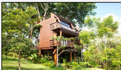
Vista externa Fuente: Archdaily
