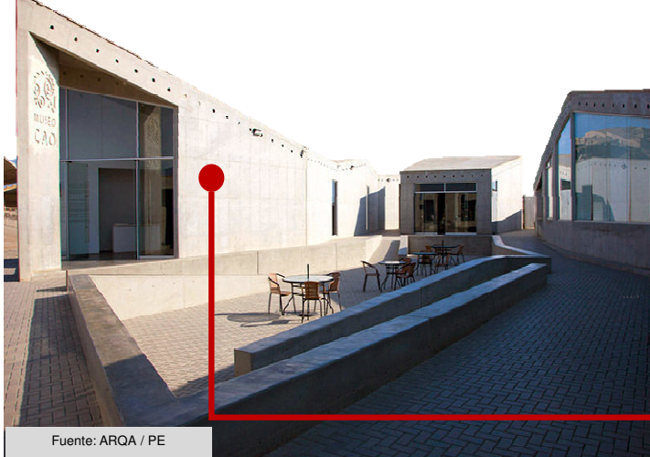
Fuente: ARQA / PE
