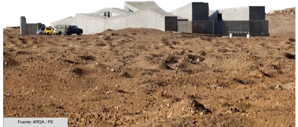
Fuente: ARQA / PE
