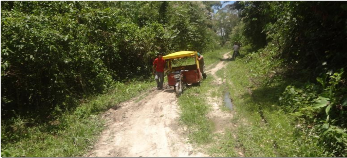
Tramo crítico, donde se constata el difícil acceso vehicular, todo ello debido a la falta de mantenimiento que recibe la vía. km 11+345.
