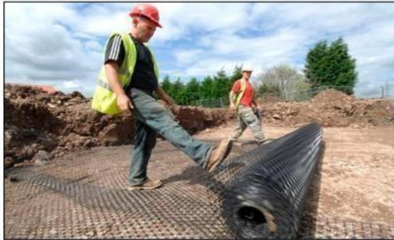
Figura N°15: Despliegue de la geomalla en situ.
