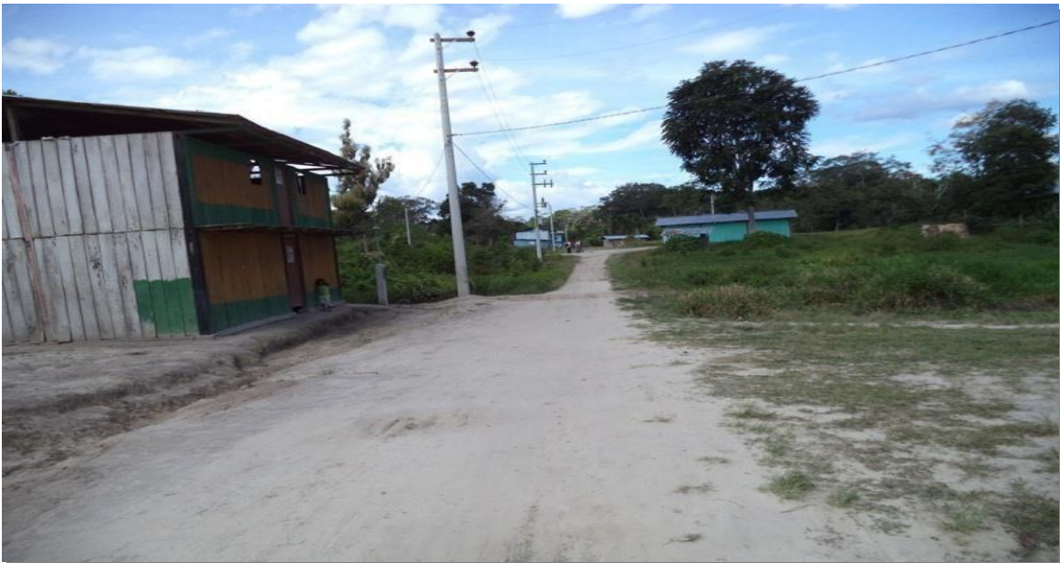
Caserío los olivos de Huascayacu, que forman parte de los beneficiarios del proyecto, que cuentan con una vía sin sistema de drenaje ni protección superficial. km 4+550.
