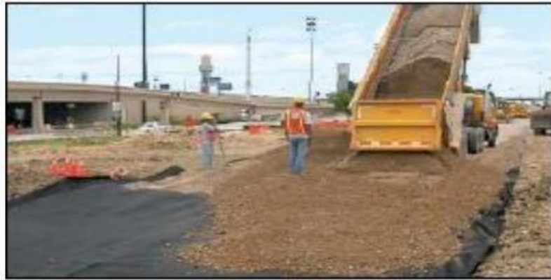
Figura N°16: Vaciado del material granular en campo.
