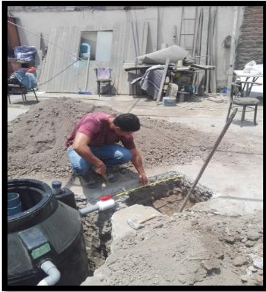
Figura 6 Construcción de Biofiltro
