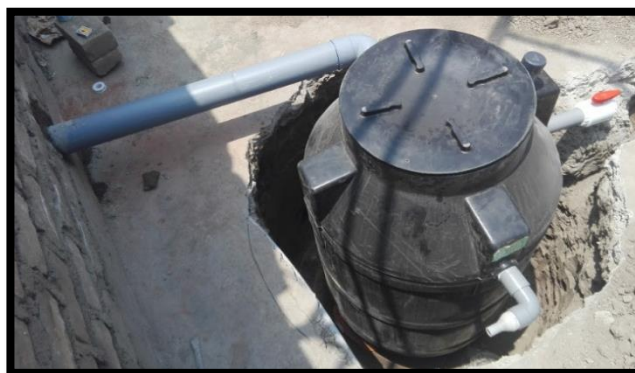
Figura 4 Conexión de baño - biodigestor
