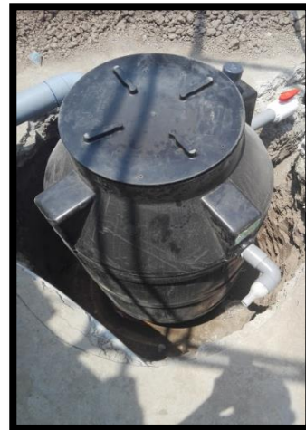
Figura 3 Excavación e Instalación de biodigestor
