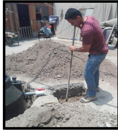
Figura 7 Conexión de tubería Biodigestor - Biofiltro
