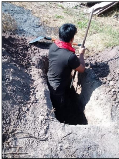
Imagen 12: excavando calicata a 3 mts de profundidad
