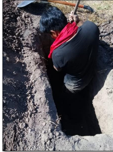
Imagen 12: excavando calicata a 3 mts de profundidad
