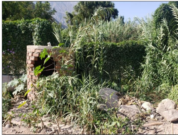
Imagen 07: la existencia de un tanque séptico sin uso, derruido según Información nunca funciona
