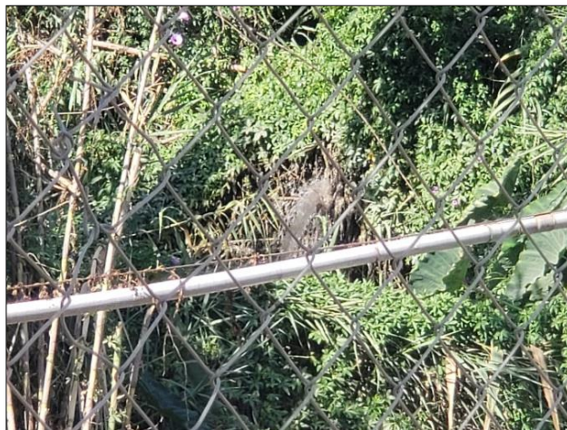
Imagen 08 : punto final de desembocadura del agua residual contaminando suelo y río.
