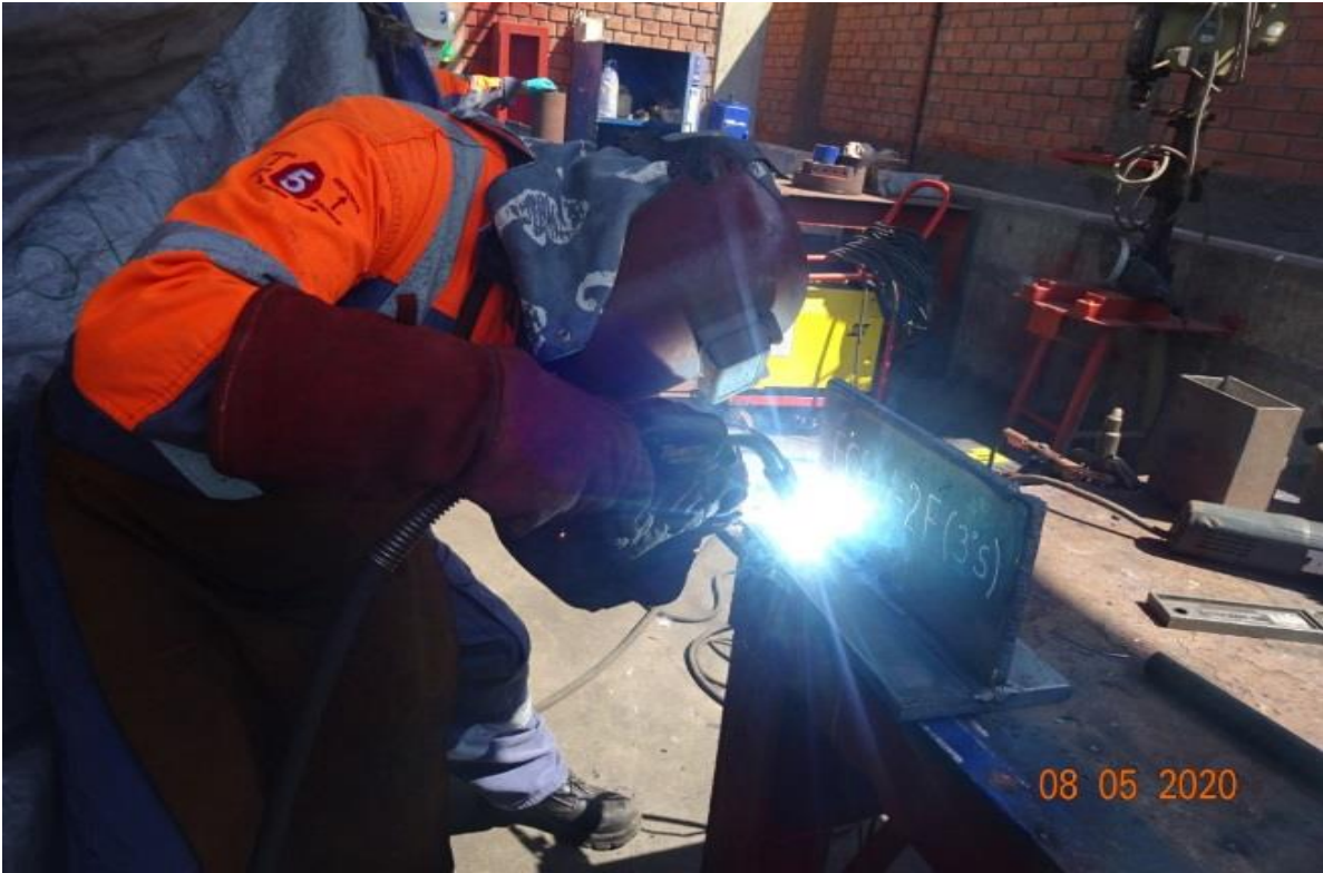
Anexo 19. Figuras utilizando soldadura FCAW
