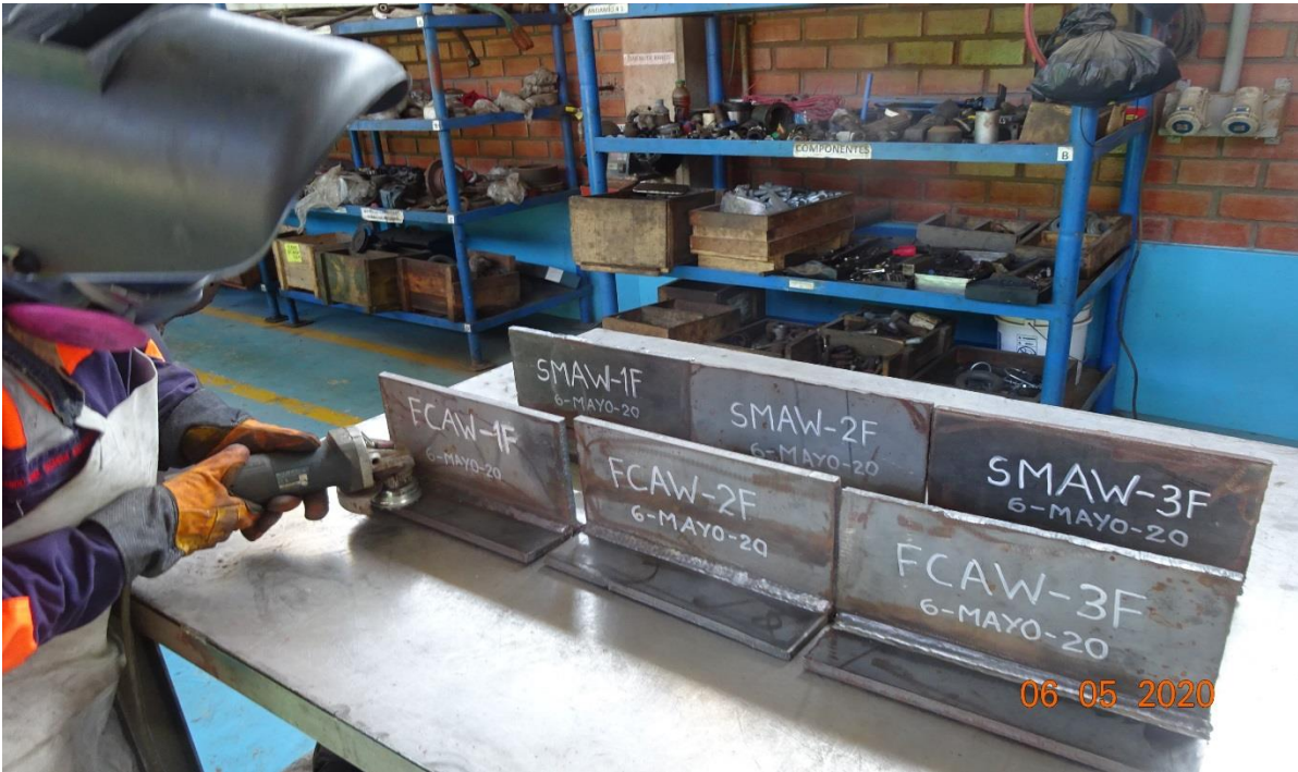
Anexo 21. Limpieza de cordón de soldadura SMAW y FCAW.
