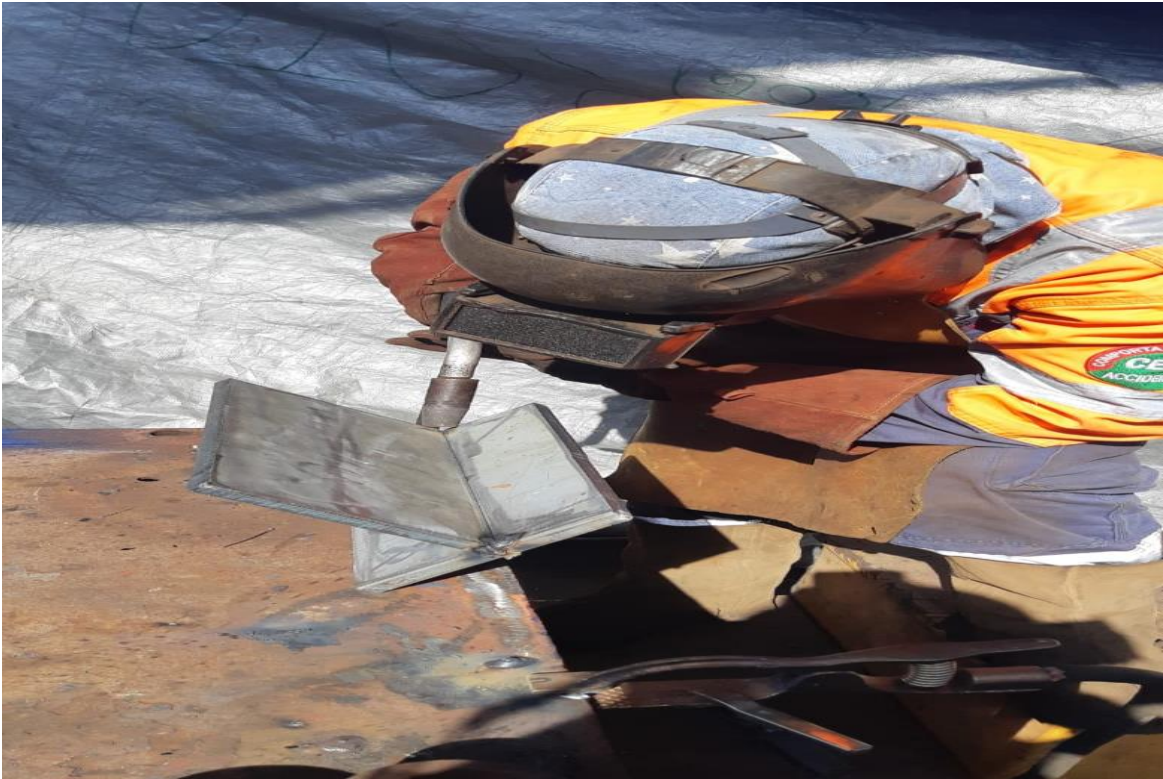
Anexo 20. Figuras utilizando soldadura FCAW
