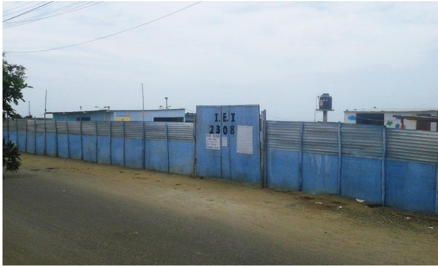
Figura 2. Cerco perimétrico de la fachada principal, elaborado de triplay, listones de madera y calamina metálica Fuente: elaboración propia. 2018.
