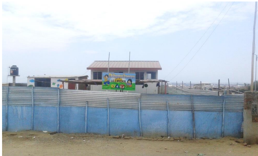
Figura 3. Cerco perimétrico elaborado de triplay, listones de madera y calamina metálica. Fuente: elaboración propia. 2018.
