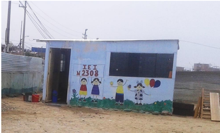
Figura 6. Aula de construida de triplay y techo de calamina metálica. Fuente: elaboración propia. 2018.
