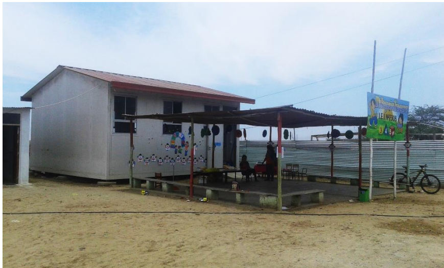
Figura 9. Aula prefabricada y patio techado con calamina plástica. Fuente: elaboración propia. 2018.
