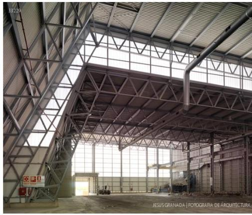
Toda la edificación de la planta de tratamiento tiene un sistema constructivo con materiales metálicos.
