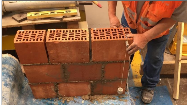
Foto 11: Control de la verticalidad del murete
