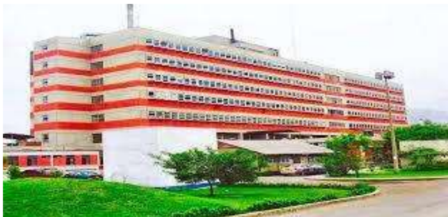
Figura 9: Fotografía del estado actual del Hospital María Auxiliadora.
