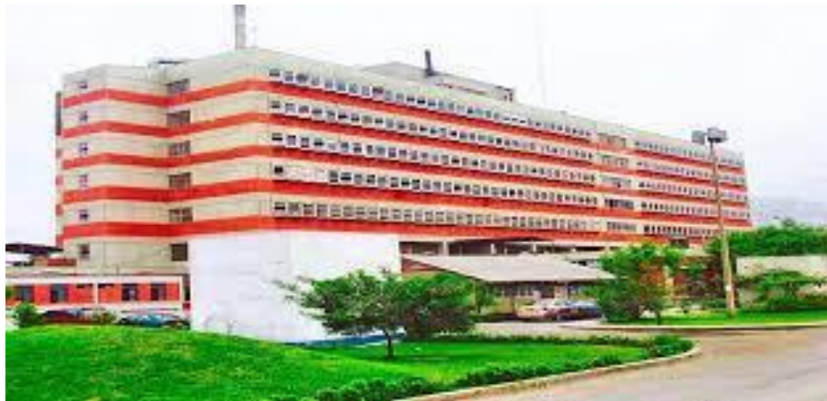
Figura 9: Fotografía del estado actual del Hospital María Auxiliadora.
