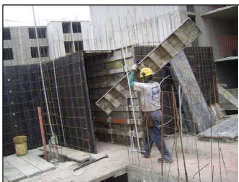
Figura 35. Encofrado de MDL
