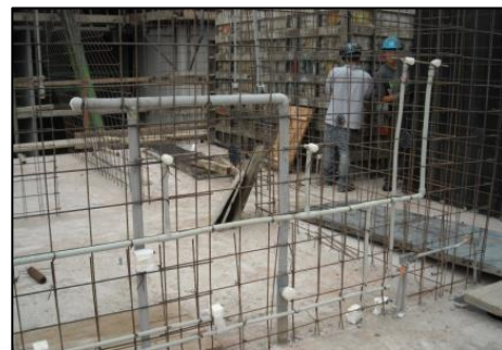
Figura 34. Inst. Sanitarias en MDL
