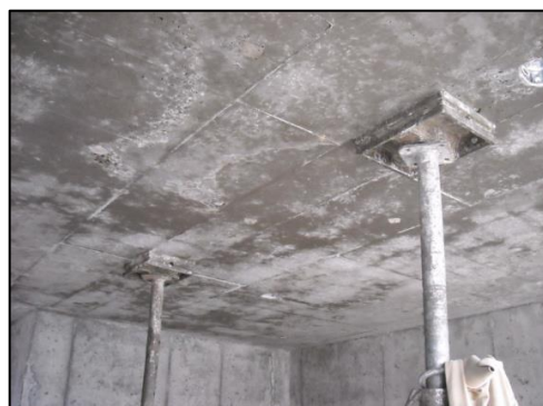
Figura 36. Losa de concreto
