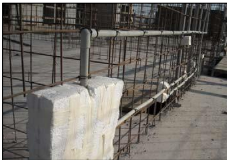
Figura 33. Inst. de Agua en MDL
