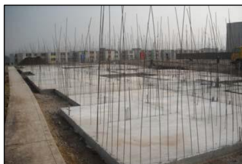
Figura 30. Platea de Cimentación
