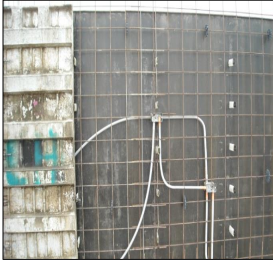
Figura 31. Inst. Eléctricas en MDL
