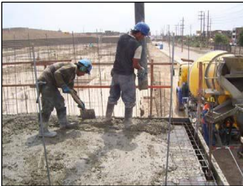
Figura 37. Vaciado de concreto en Losa
