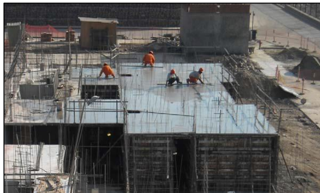
Figura 39. Estructura construida en base al Sistema de "MDL"
