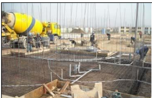
Figura 29. Armadura de la Platea
