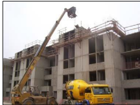
Figura 38. Vaciado de concreto con Maquinaria
