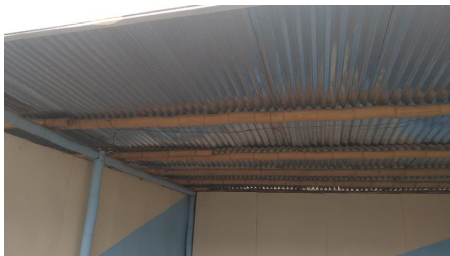
Techo de calamina para aulas de nivel primario Fuente: Elaboración propia
