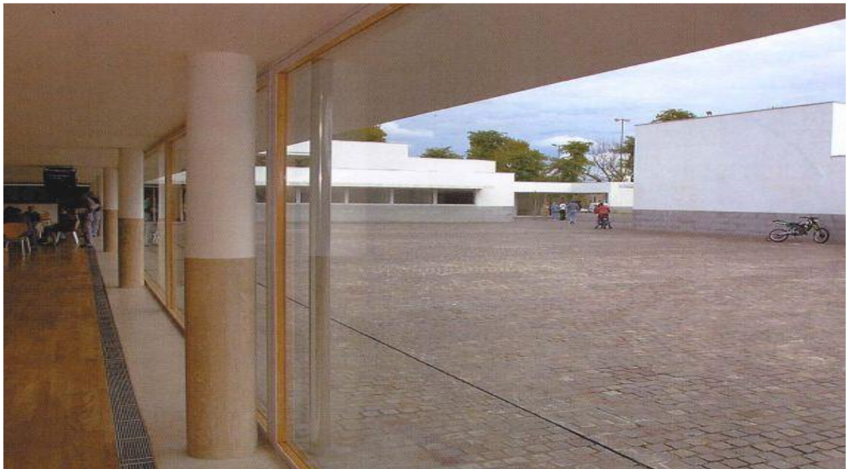
Fig. N° 8 – Vista desde los ambientes internos del centro juvenil del Rosario – Argentina – Fuente: https://www.rosario.gov.ar/web/ciudad/distritos/distrito-sur/centro-municipal-de-distrito-sur-rosa-ziperovich
