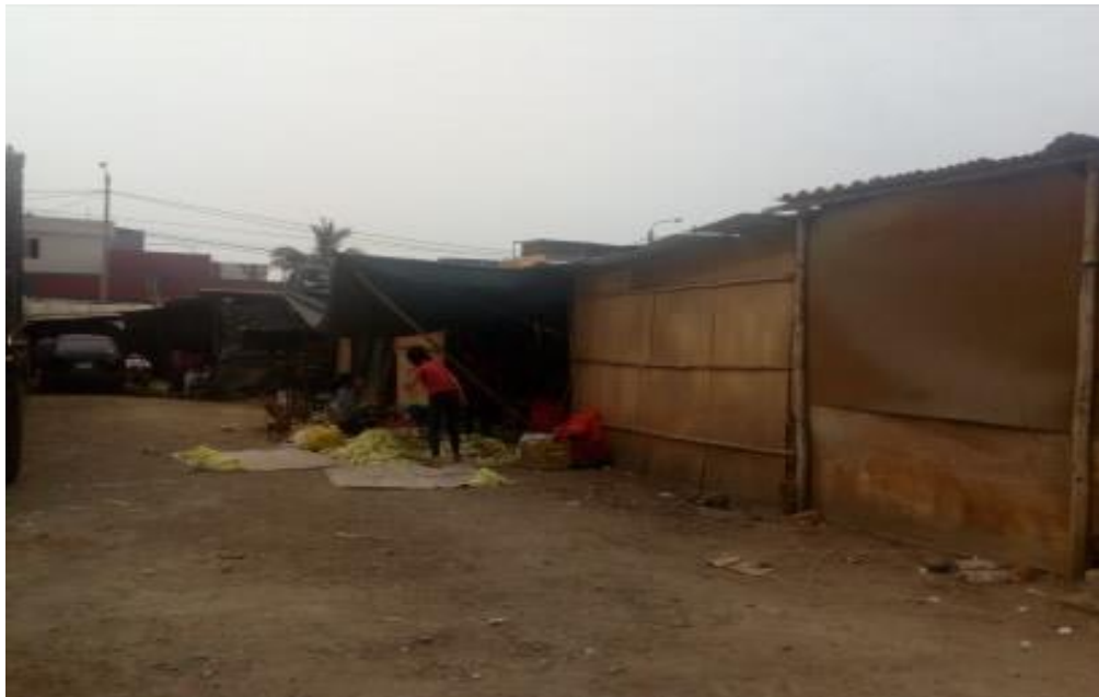
Figura 22: Mercado Improvisado en una cochera material inflamable e insalubrida
