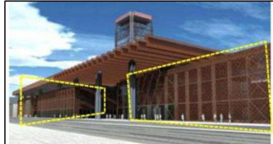
El edificio cuenta además, con cristal laminado Salvid Seguridad incoloro de 10 mm. De espesor el cual otorga gran transparencia, seguridad antirrobo y seguridad personal. En su interior, tiene un vitral de 600m2 con Salvid Colour, el cual brinda un moderno diseño lleno de color que da vida a este Centro Cultural.
