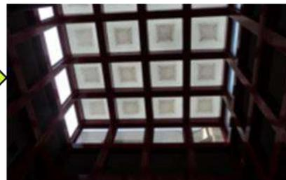
El espacio central presenta una estructura de metal en forma de red que funciona como muro transparente y tragaluz, de manera que no solo se vuelve un muro portante, sino que ayuda a ingresar luz natural a todo el corazón del edificio.
