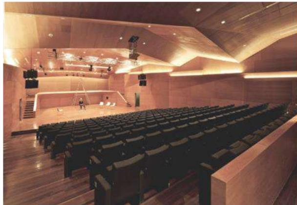
El diseño de cada caso pasó por un diseño propuesto por arquitectura en coordinación con el especialista acústico. De esta forma, por ejemplo, la Sala de Música presenta un diseño de planos inclinados y con quiebres que son capaces de dirigir el sonido a todos los espectadores de buena forma y al mismo tiempo le entregan a la sala una expresión contemporánea y cálida.
