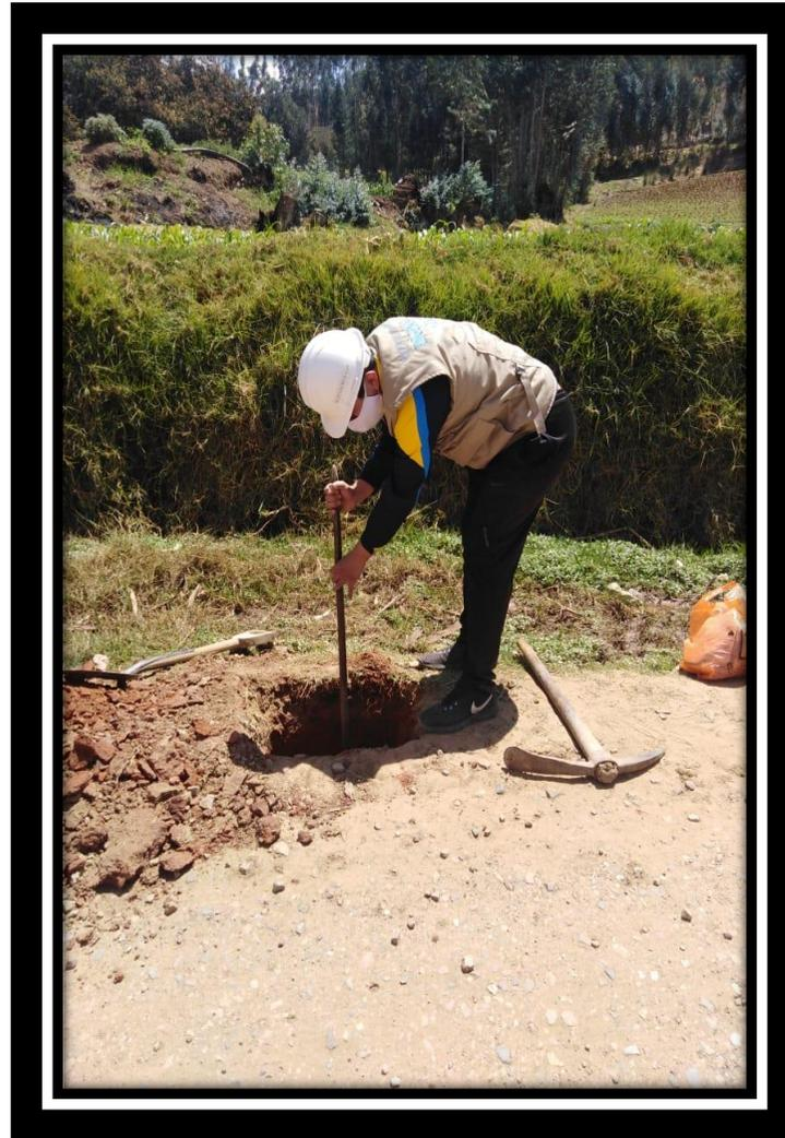
**Fotografía 5:** Proceso de excavación de la calicata N°2
