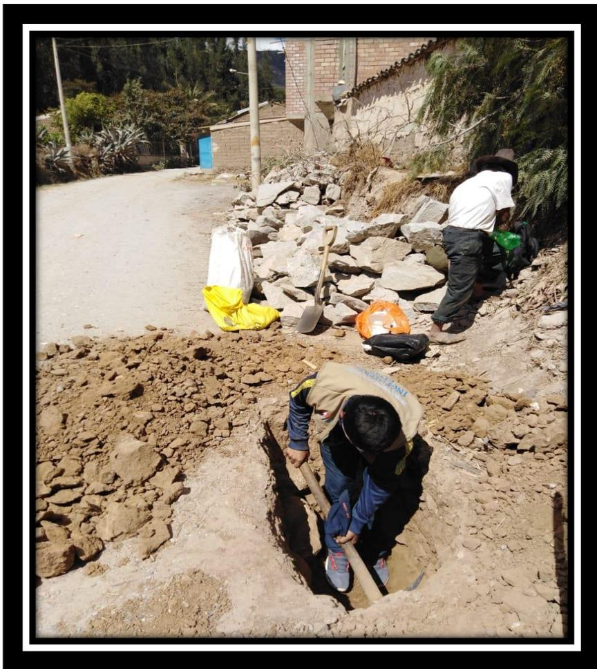
**Fotografía 6:** Proceso de excavación de la calicata
