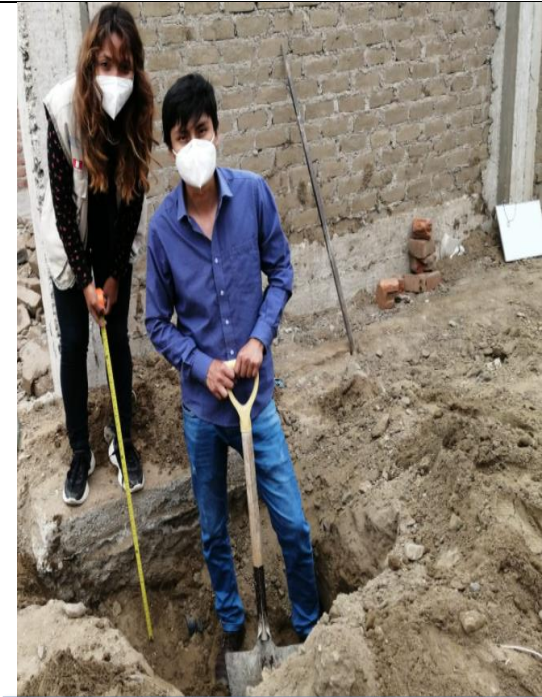
Excavación de calicatas
