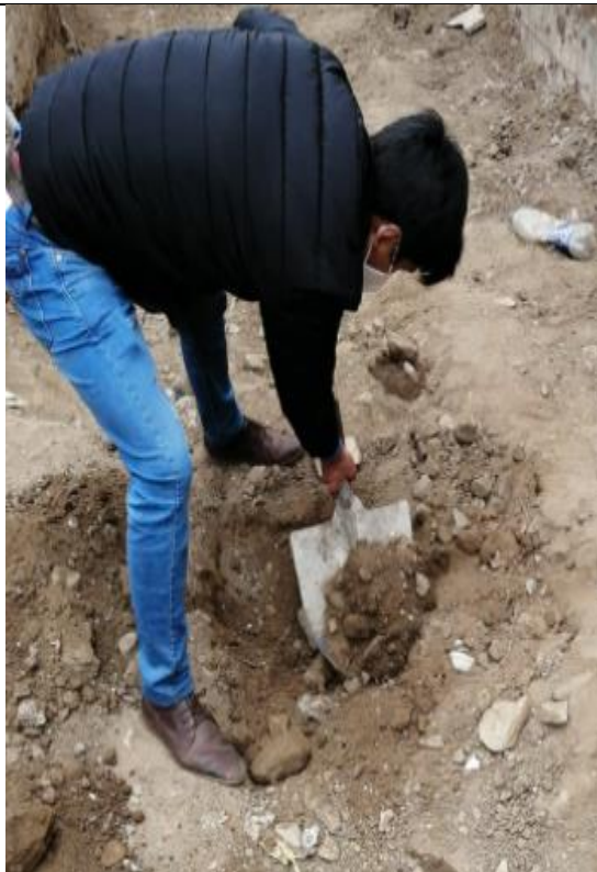
Excavación de calicatas día 2
