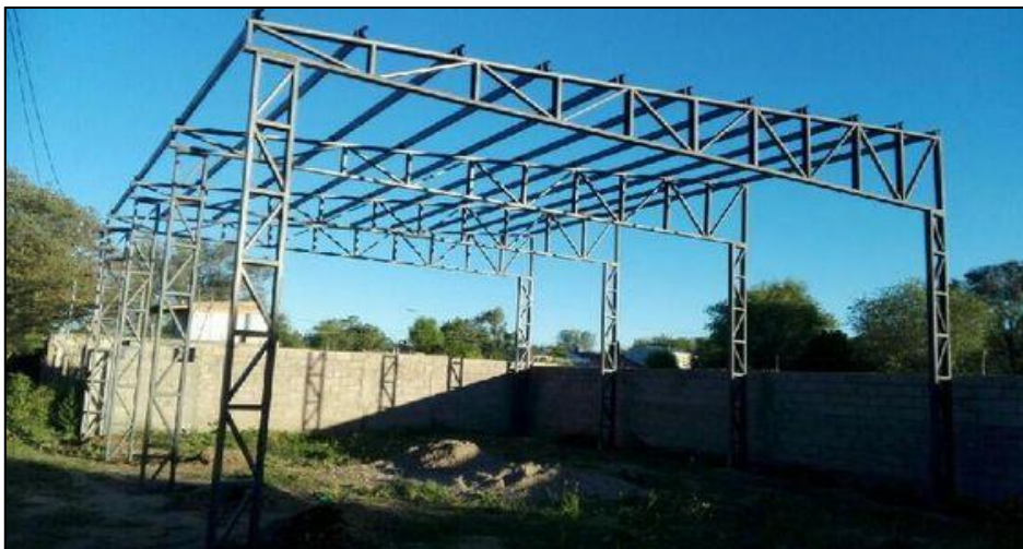
Figura 3. Diseño de armadura a un agua
