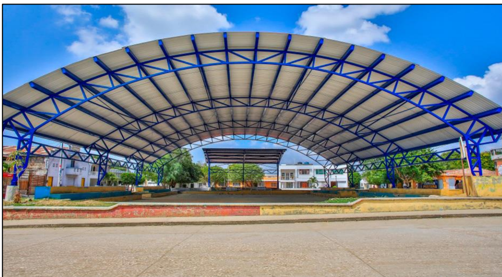
Figura 1. Diseño de armadura parabólica
