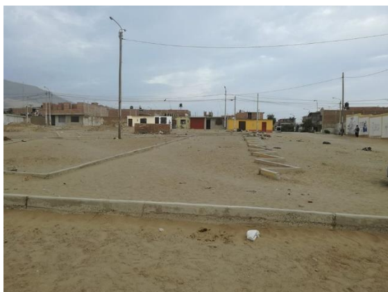
Figura 34. Estado de los parques del sector. Fuente: Elaboración propia.
