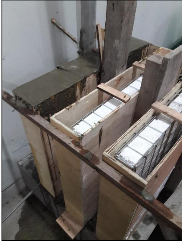
*Figura 47. Vaciado del Mortero*
