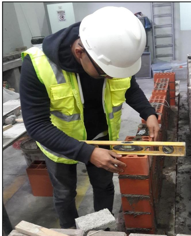
*Figura 32.* Regla de Nivelación de la 4ta hilada de los muretes
