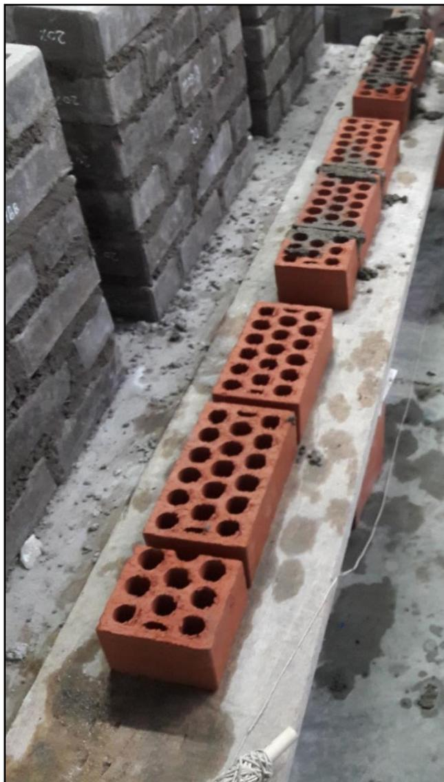
*Figura 28.* Primera hilada de ladrillos para el murete
