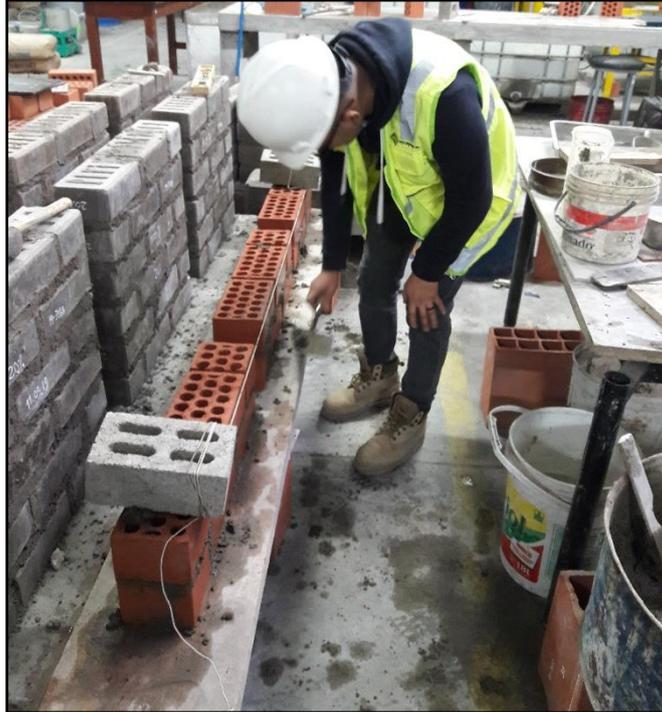
*Figura 29. Colocación de la segunda hilada*
