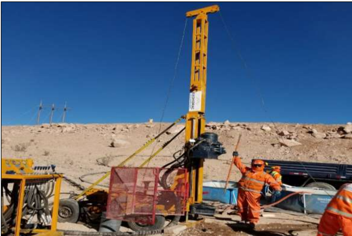
Descripción: Ejecución de la Perforación Diamantina.
