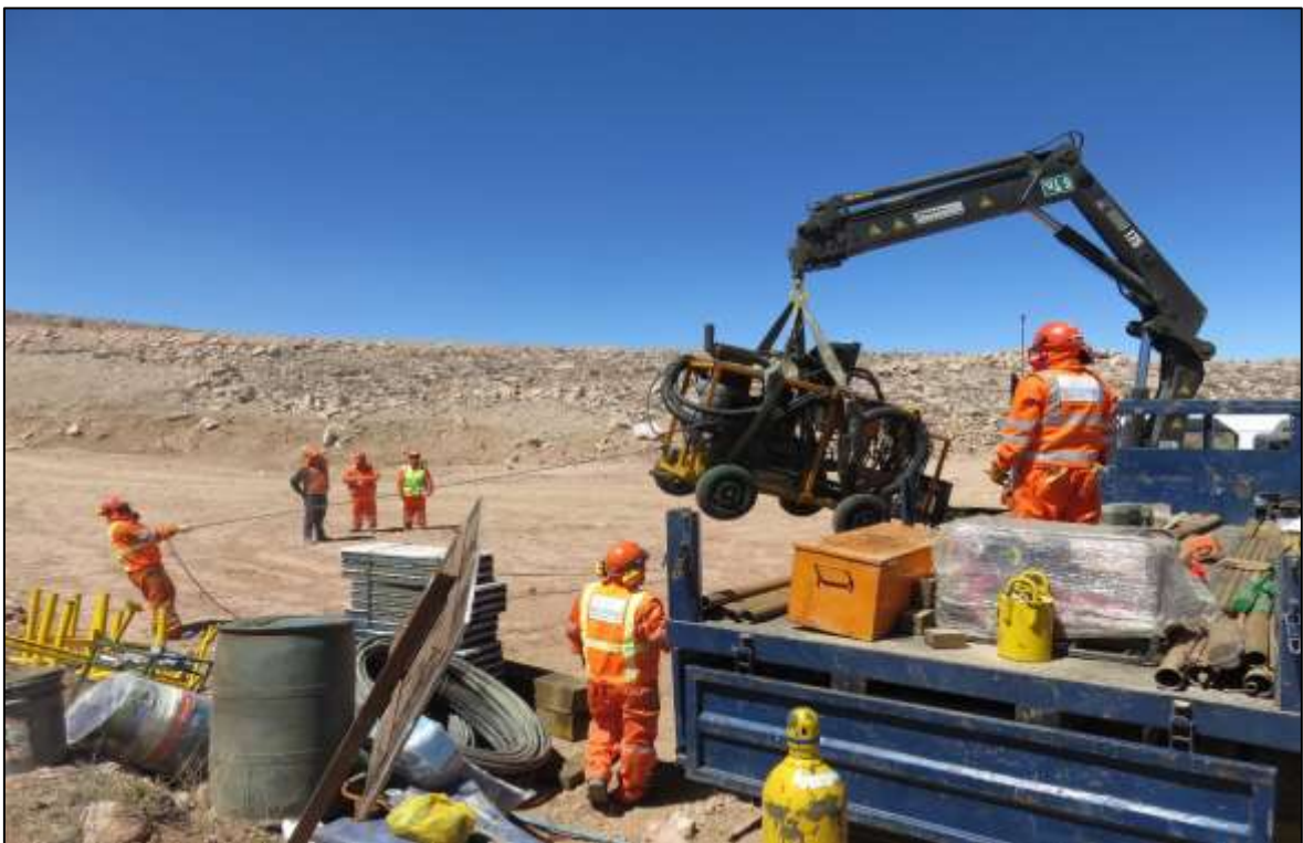
Descripción: Izaje – descarga de la máquina perforadora.
