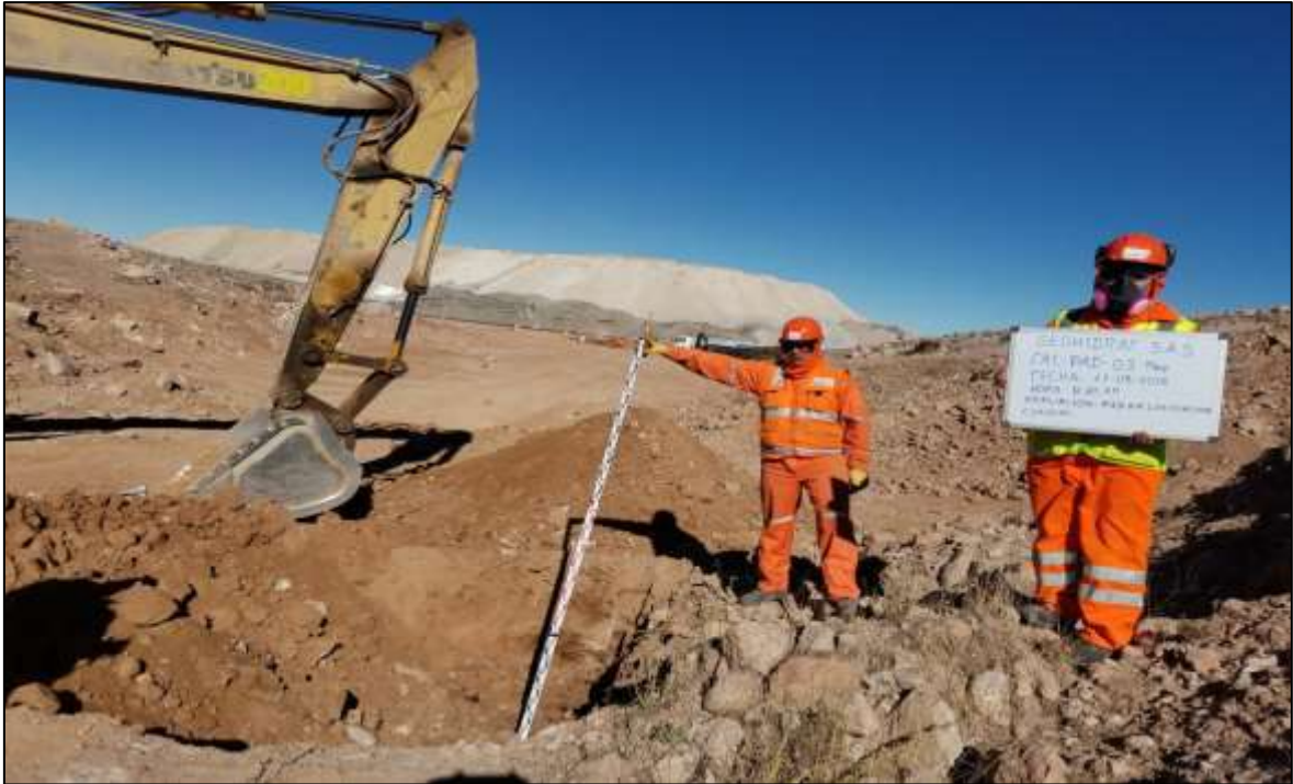
Descripción: Ejecución mecanizada de Calicatas.
