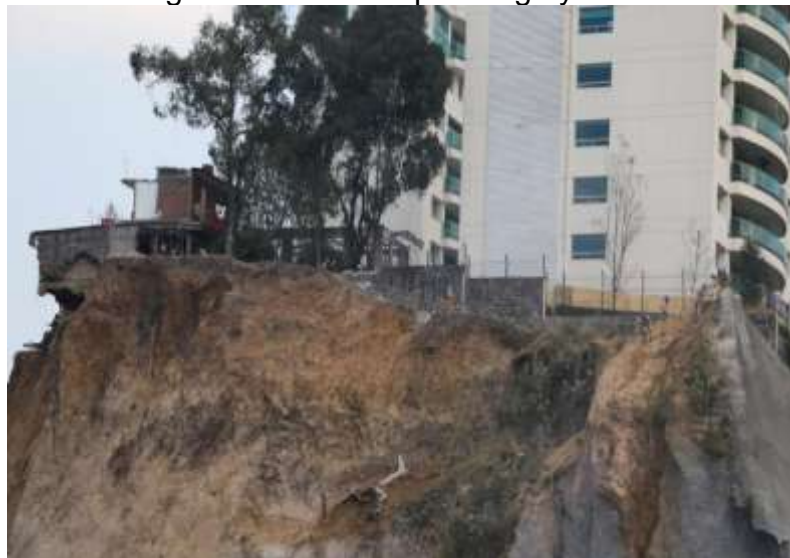
Figura N° 14: Falla por carga y sismo
