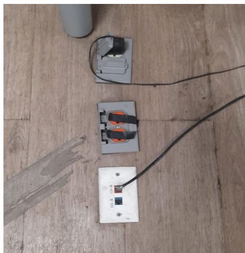
Figura 11. Interruptores defectuosos
