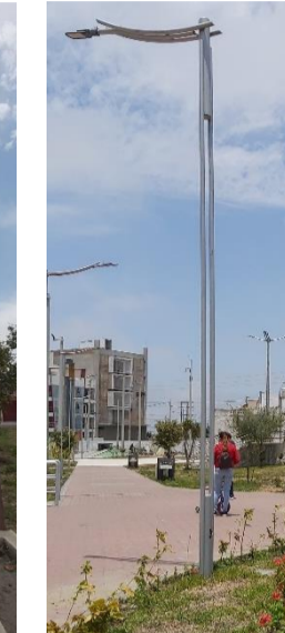
C Poste de alumbrado
