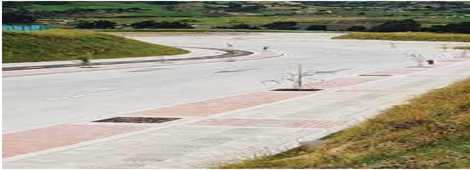
Figura 14: Calle pavimentada con CCR (CEMEX)
