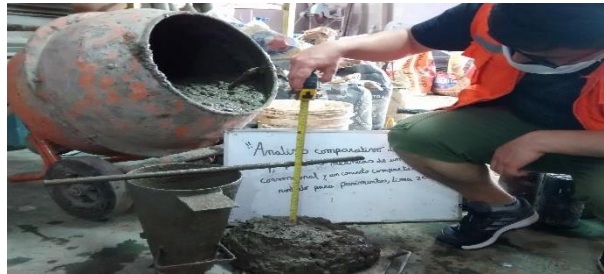
Figura 22: Medición del Slump
