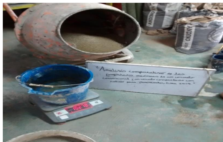
Figura 28: Pesaje del agua del concreto convencional.
