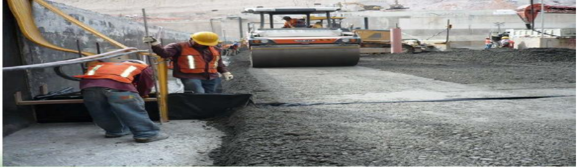
Figura 11: Aplicación del CCR en presas (Orellana y Carrillo Vásquez, 2003)
