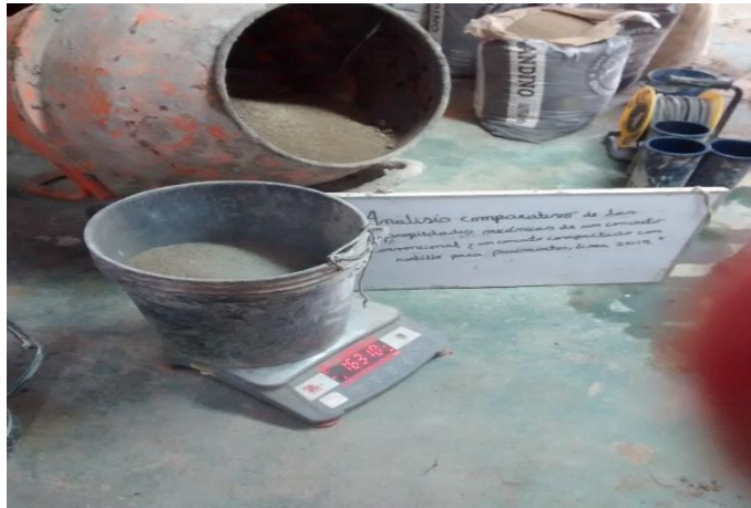
Figura 26: Pesaje del agregado fino del concreto convencional.
