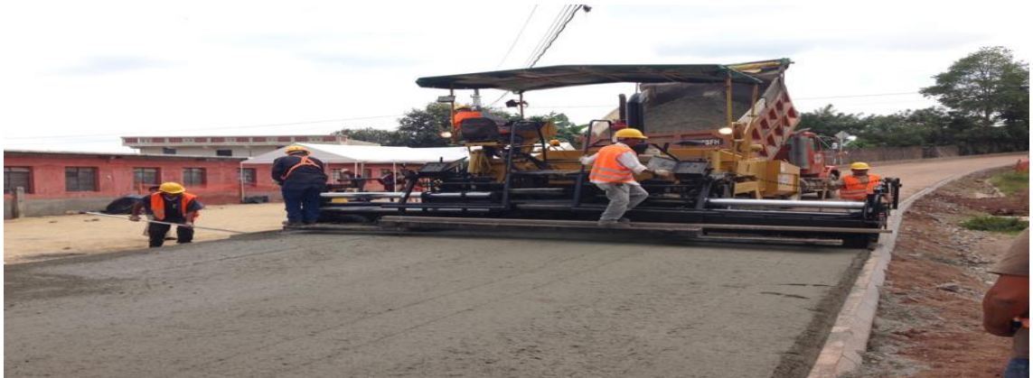
Figura 12: Pavimento del CCR
