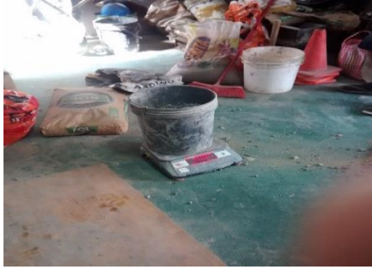
Figura 33: Pesaje de los agregados finos y grueso del CCR
