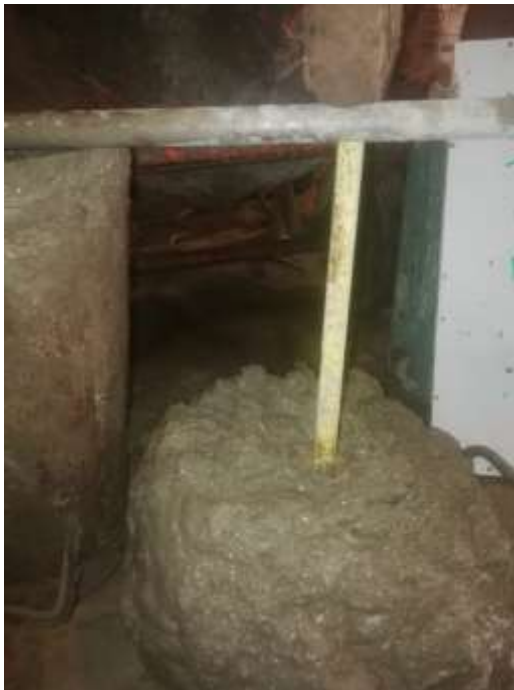
Ensayo de módulo slump del concreto patrón.
