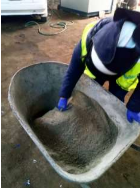
Figura 21. Preparación de la mezcla en seco- batido.
