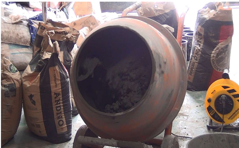
Figura 19. Elaboración de la mezcla para el vaciado de las vigas
