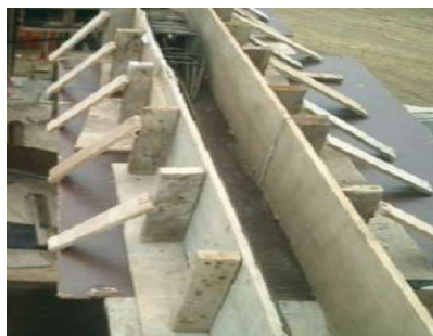
Figura 17. Encofrado para las vigas.
