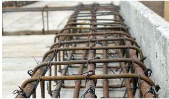
Figura 18. Armado de las vigas.
