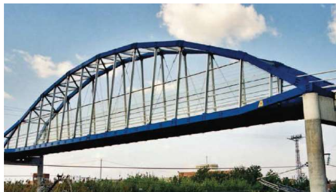
Figura 3. Puente sobre ferrocarril Lleida.
