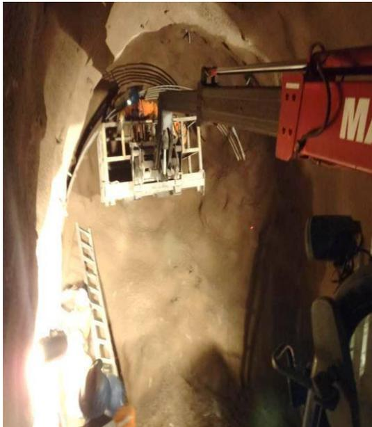
Ensayo Pull Test de pernos anclaje de la progresiva 1+093.60 Km.
