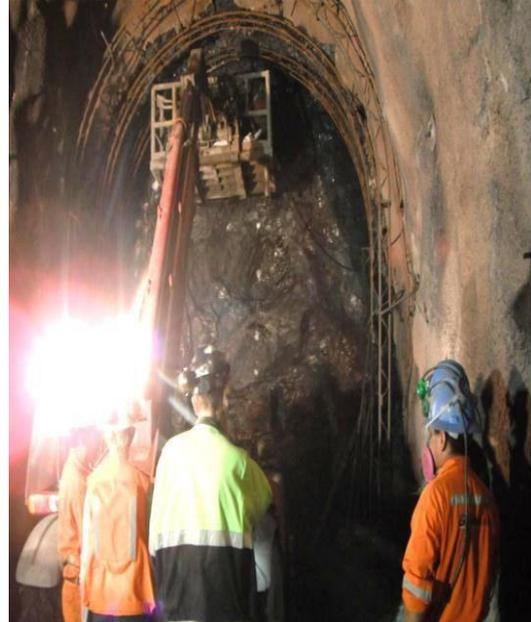
Ensayo Pull test de pernos de anclaje de la progresiva 1+027.00 Km.
