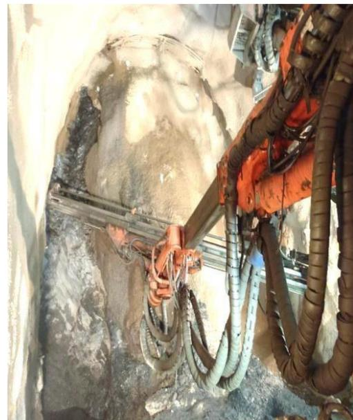
Colocación de pernos de anclaje en la progresiva 1+101.00 Km.
