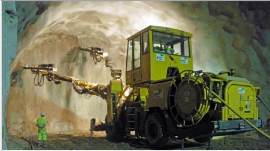
Figura 8. Maquinaria para la perforación del túnel
