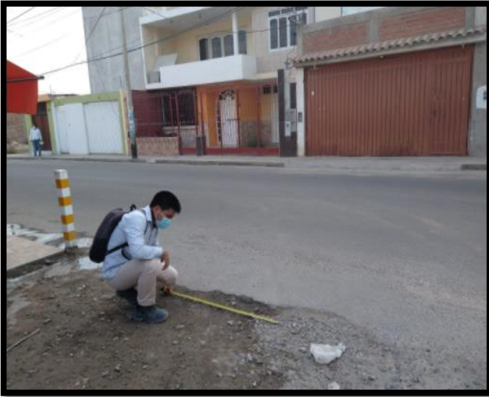
Figura N°44: Grieta de borde
