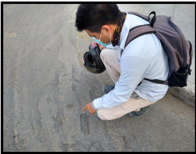
Figura N°46: Ahuellamiento
