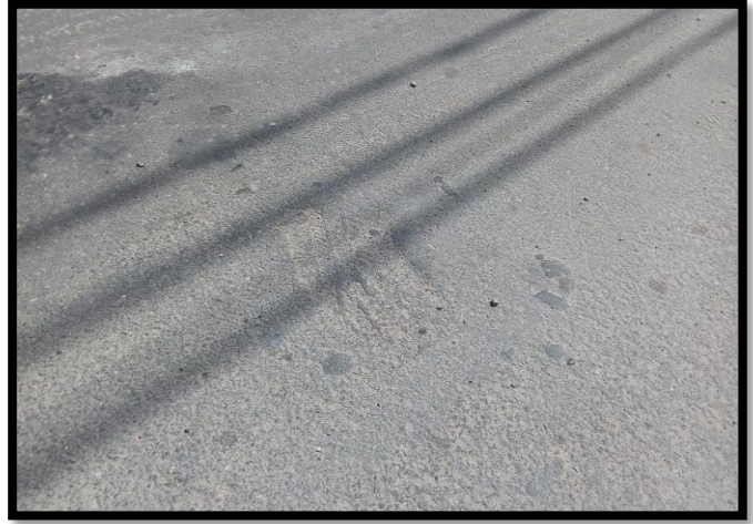
Figura N°41: Ahuellamiento
