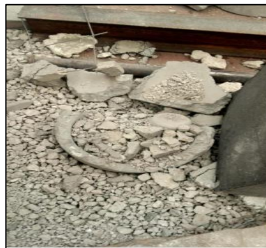
Imagen N° 28 Producto defectuoso Fuente: propia
