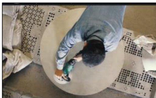
Imagen N° 23 Lijado con amoladora Fuente: propia
