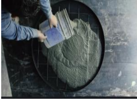
Imagen N° 18 Llenado Fuente: Propia
