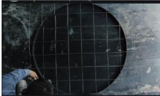
Imagen N° 16 Armado con alambrón Fuente: Elaboración propia
