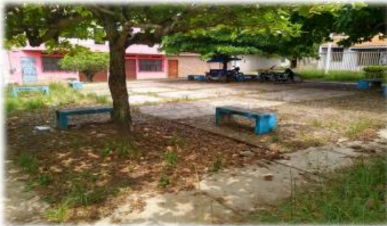
MOBILIARIO URBANO EN MAL ESTADO
