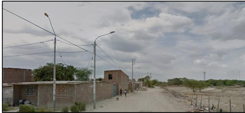
Figura 20: Servicios de electricidad y alumbrado público en el terreno
