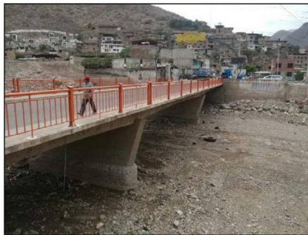
Fig. N° 4 - Vista del Puente
