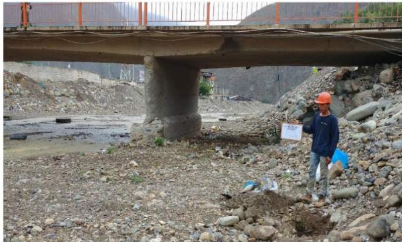
Fig. N° 38 - Calicata CBH3-01, Vista Panorámica de Calicata
