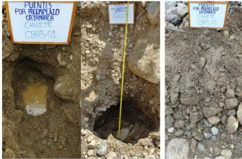
Fig. N° 37 - Calicata CBH3-01, Vista De Excavación de Calicata
