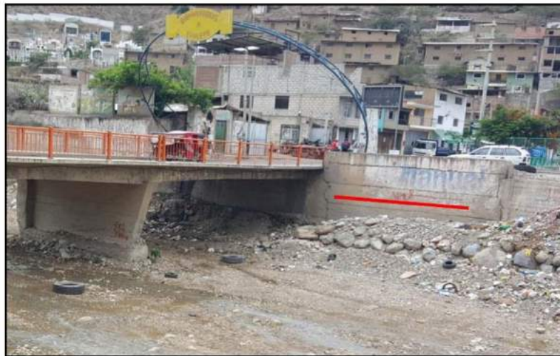
Fig. N° 31 - Mediciones Tomadas Insitu, para la calibración de caudales, nivel máximo línea roja
