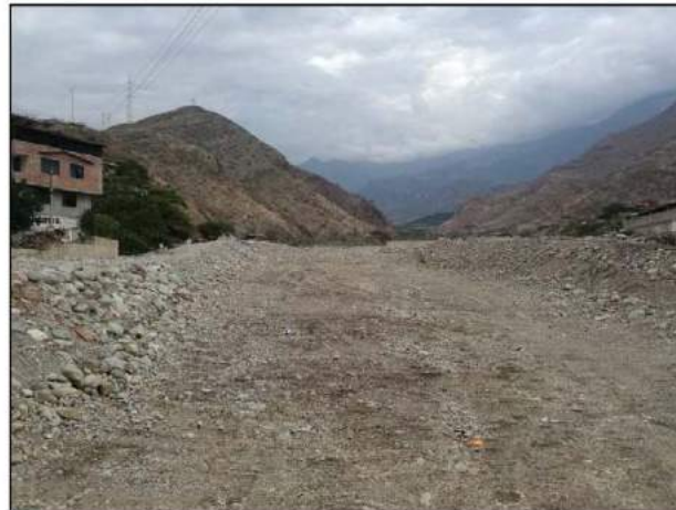
Fig. N° 5 - Vista de la quebrada aguas arriba
