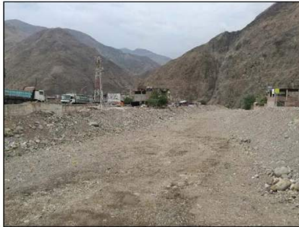
Fig. N° 6- Vista de la quebrada aguas abajo
