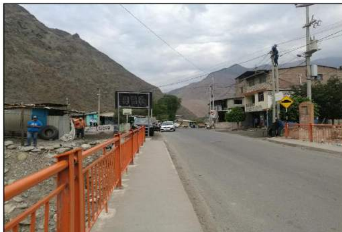
Fig. N° 10 –Sin Drenaje transversal
