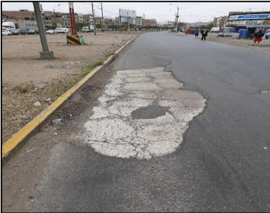
Inspección visual del pavimento
