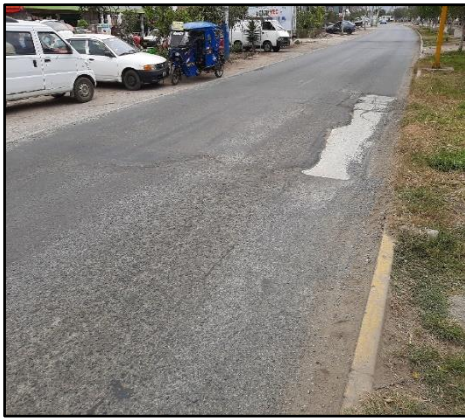
Inspección visual del pavimento
