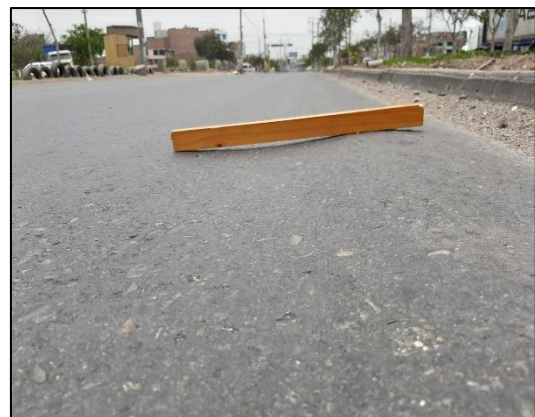
Inspección visual del pavimento
