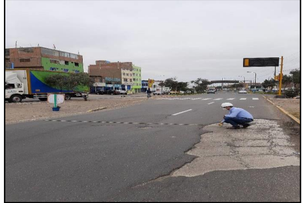
Medición del ancho de la vía
