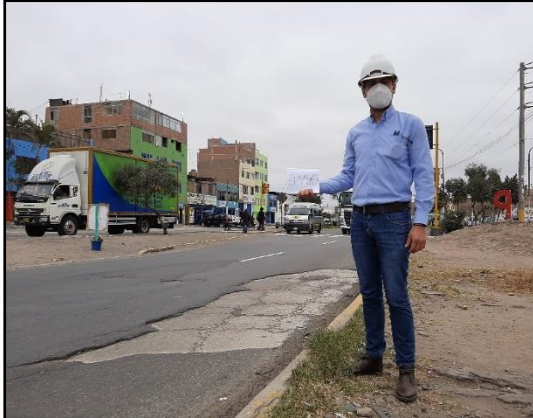
Inspección visual del pavimento
