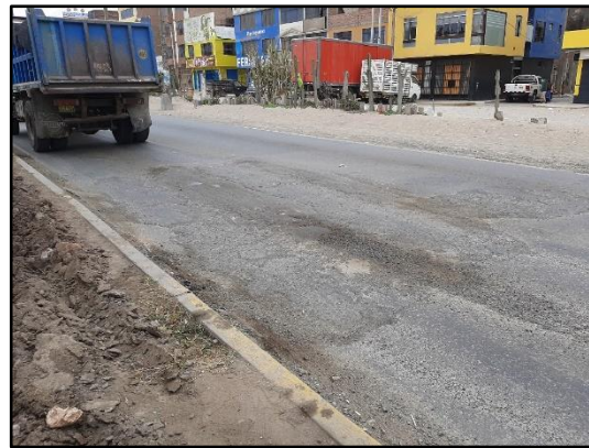
Inspección visual del pavimento
