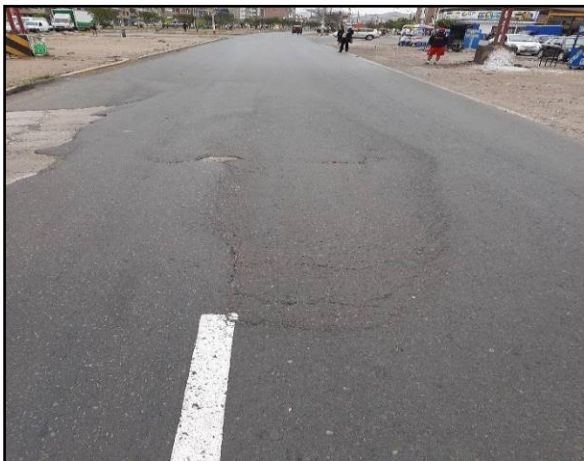
Inspección visual del pavimento
