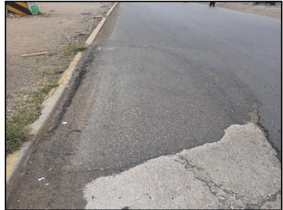
Inspección visual del pavimento
