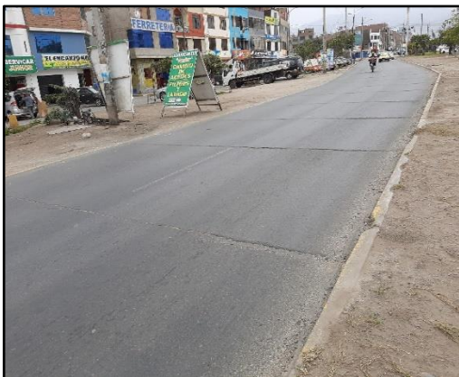
Inspección visual del pavimento
