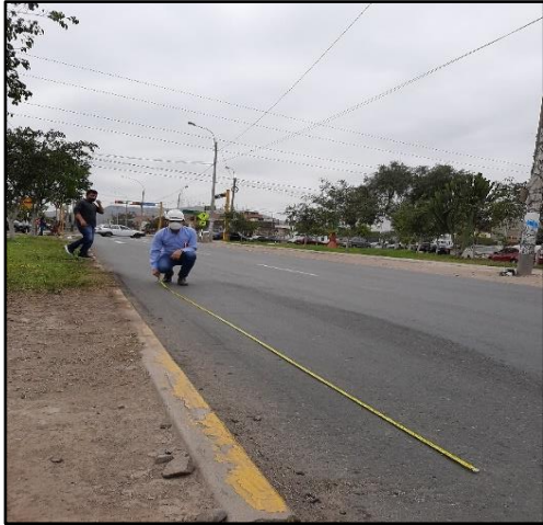
Inspección visual del pavimento
