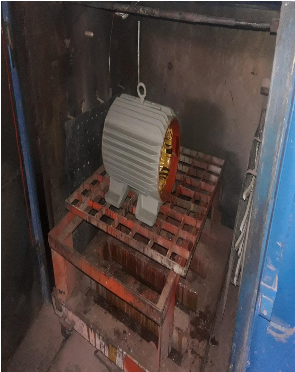
Figura 8. Foto del proceso de barnizado de estator
