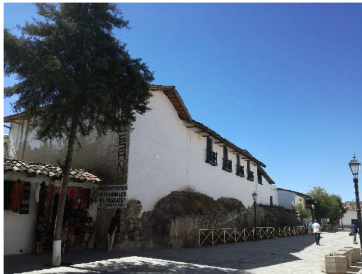
Figura 77: Jr. El Comercio, construcción de adobe del hogar de niñas de la Beneficencia que se asienta sobre muros incas
