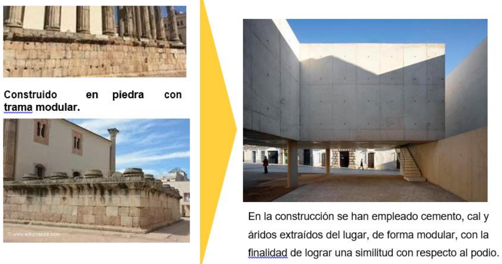
Figura 31: Análisis del planteamiento arquitectónico de intervención, materialidad
