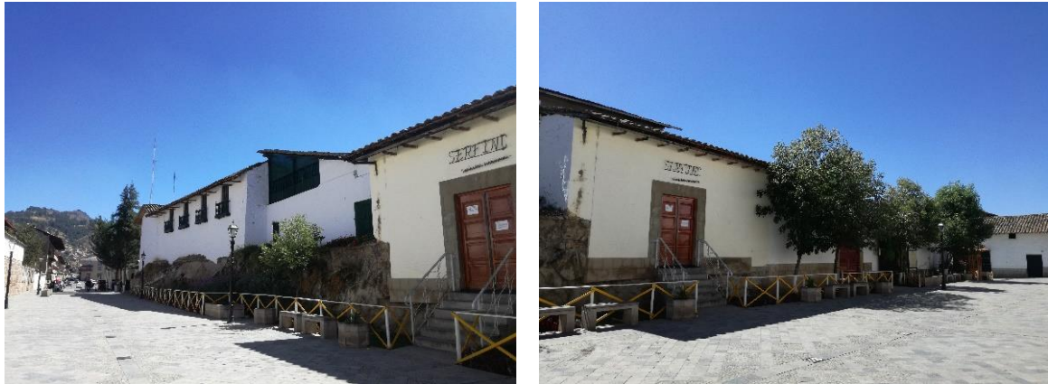
Figura 8: Jr. El Comercio – 2018, estado actual de imagen de fachadas ciegas que carecen de valor urbano y arquitectónico
