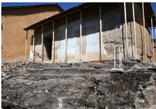
Figura 66: Apuntalamiento de techo Cuarto del Rescate – 2002
