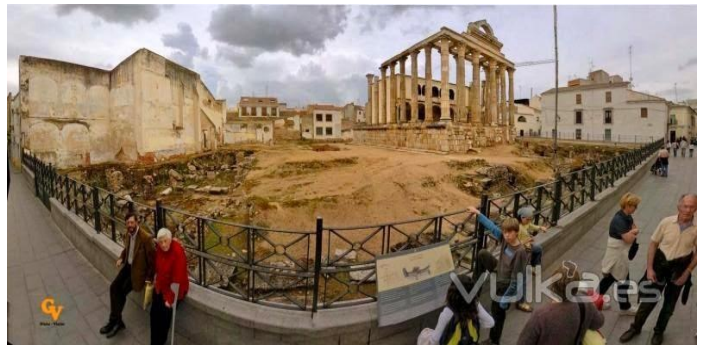
Figura 22: vista lateral externa estado actual
