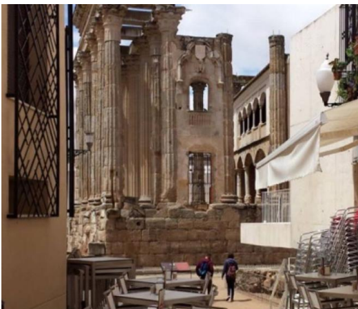
Figura 21: vista lateral interna estado actual
