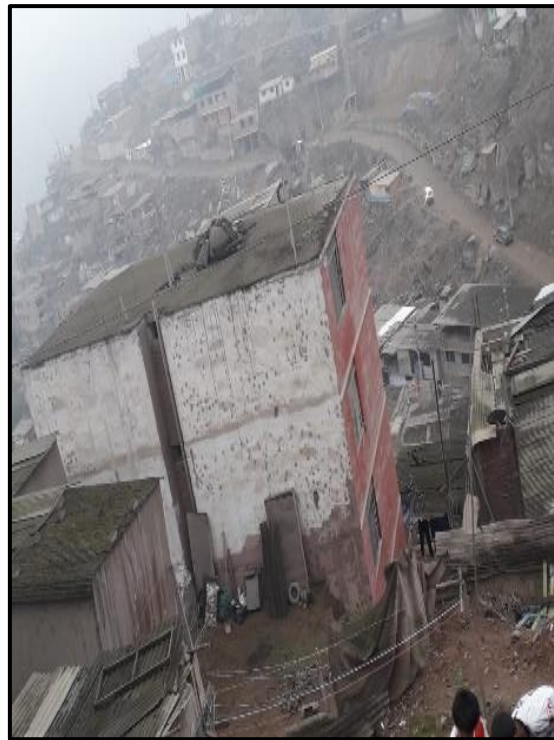
Edificación de vivienda que no cumple los parámetros de acuerdo a la zonificación
