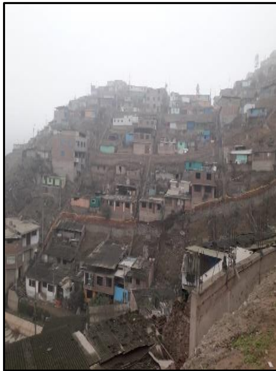
Construcción de muro de forma empírica
