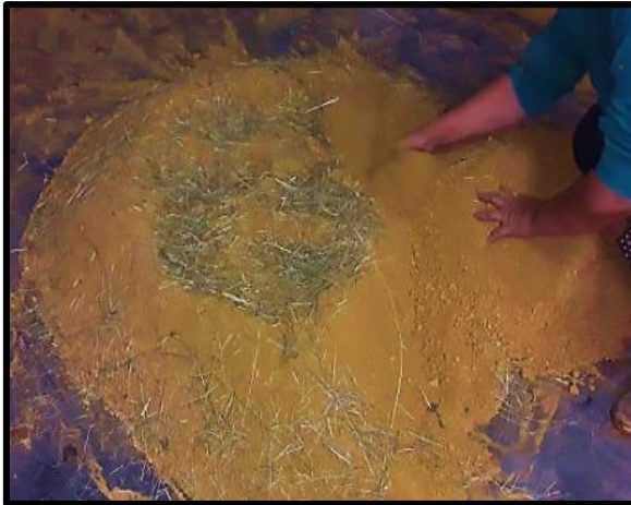
Figura N° 3-27 y 3-28 Mezcla del Material con la paja y agua
