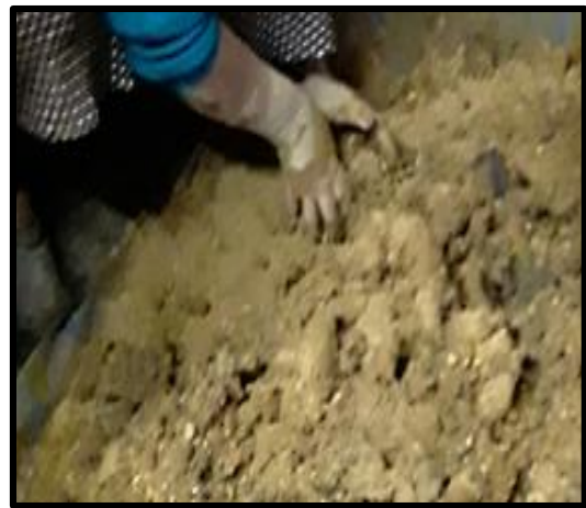
Figura N° 3-27 y 3-28 Mezcla del Material con la paja y agua
