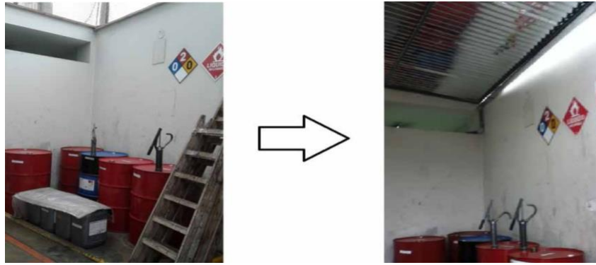
Figura 21. Instalación de techo en zona de aceites.
