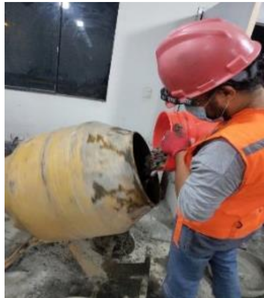
Foto 32. Colocación de materiales en el trompo para la elaboración de concreto patrón
