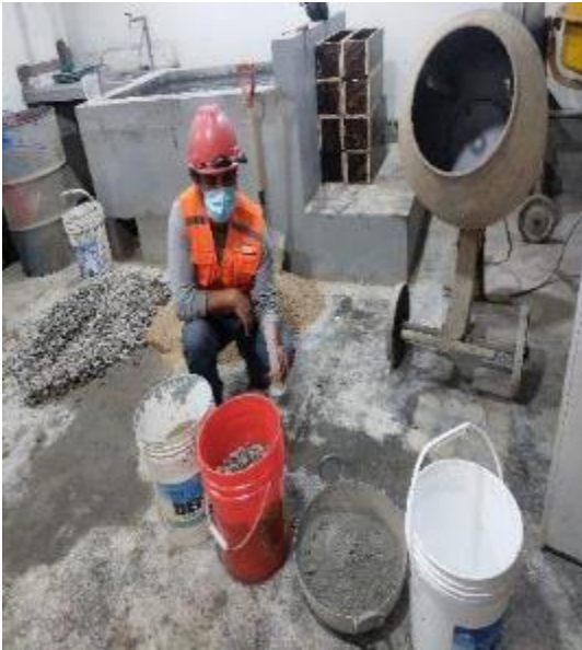
Foto 31. Materiales para la elaboración de probetas de concreto
