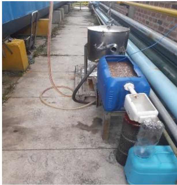
Figura 11. PTAR piloto en sistema continuo
