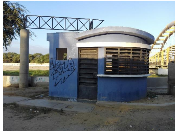
Imagen 02: Los servicios complementarios del malecón están inhabilitados.
