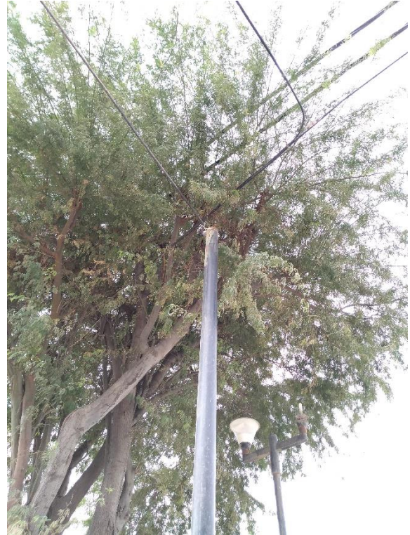
Imagen 32: Cableado eléctrico interrumpido por la copa del árbol, falta de mantenimiento a la vegetación.
