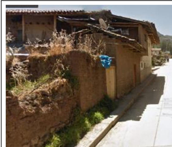
Figura 2. Viviendas existentes en el lugar.
