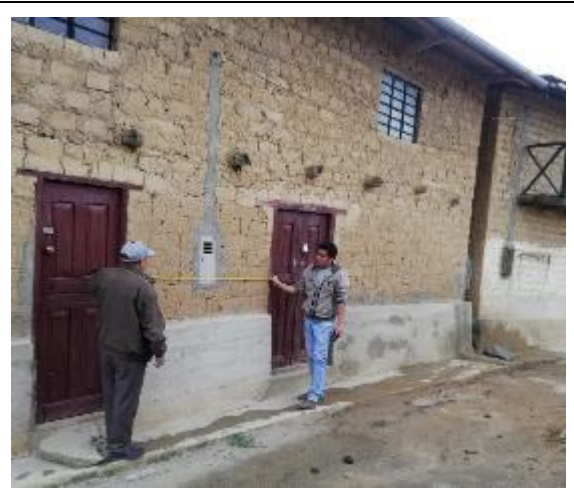
Figura 3. Viviendas existentes en el lugar.
