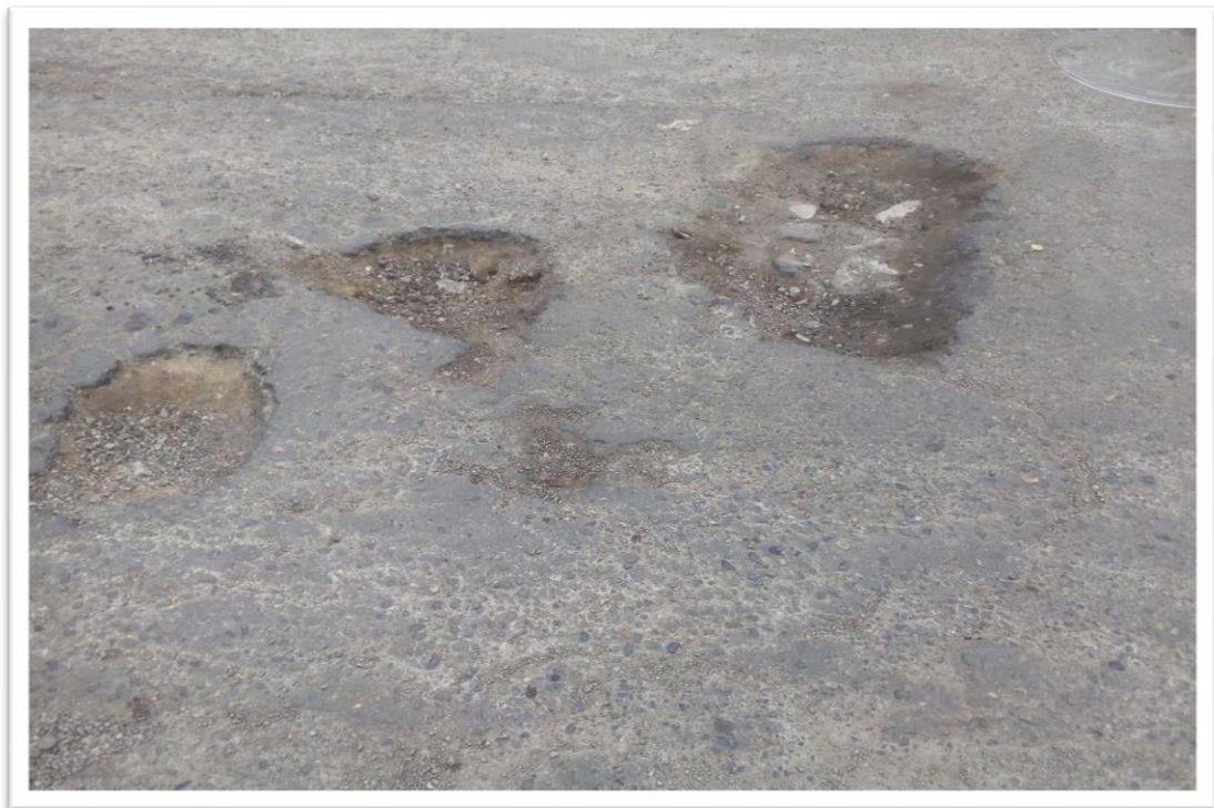
FALLA HUECOS (Nivel de severidad Intermedio)
