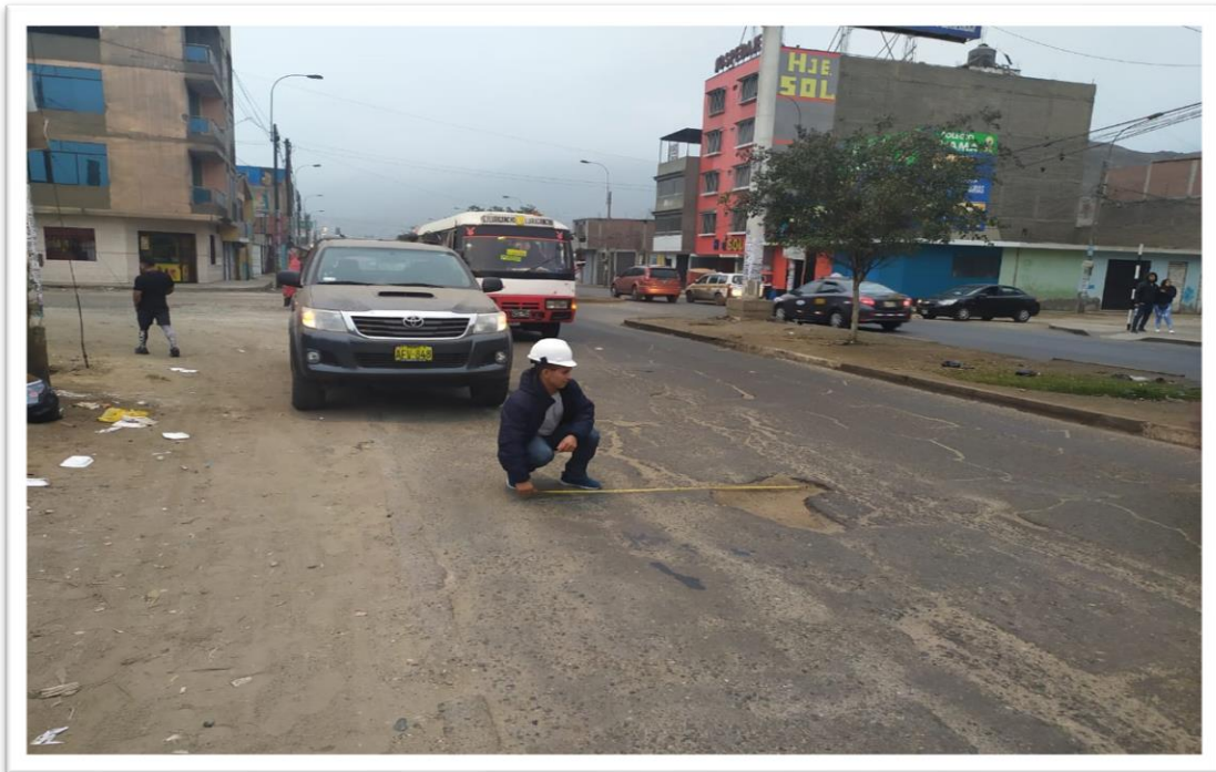
FALLA HUECOS (Nivel de severidad Intermedio)
