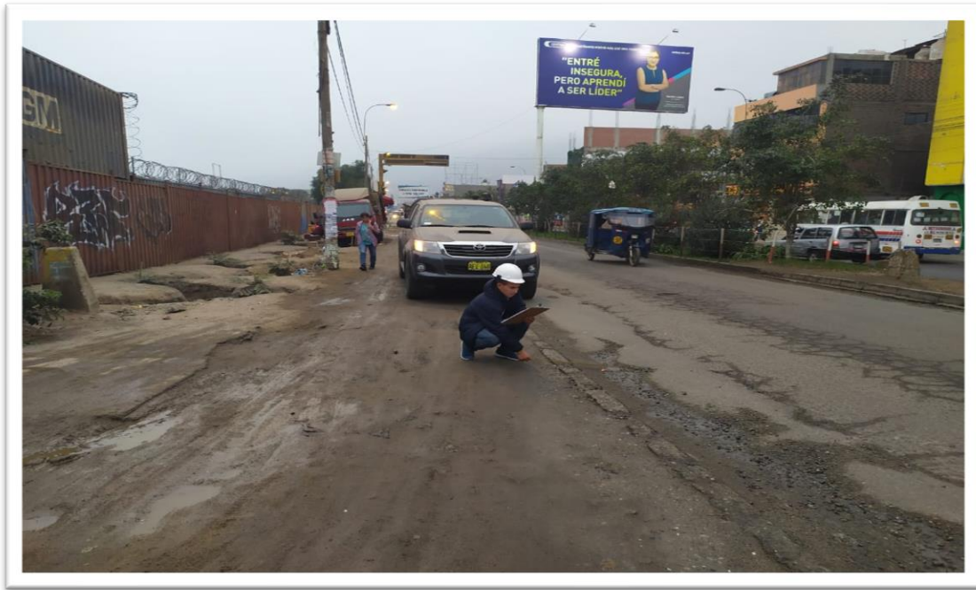
FALLA GRIETA DE BORDE (Nivel de severidad Intermedio)
