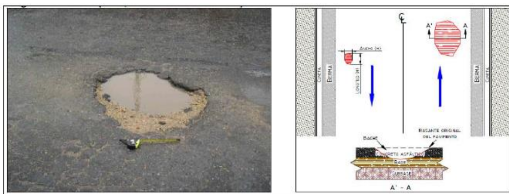
FIGURA N° 15: Huecos (HUE, unidad de medida, Unid. m 2 )
