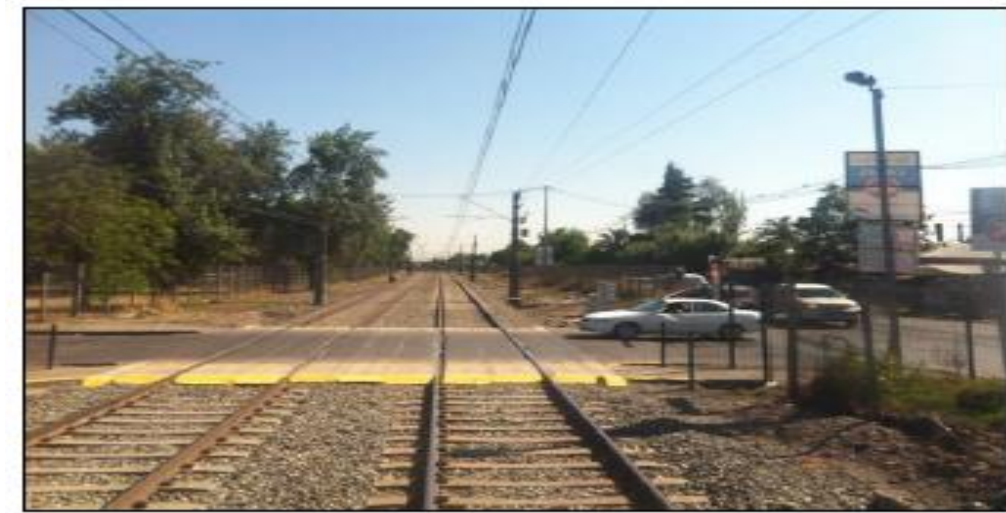
FIGURA N° 16: Cruce de Vía Férrea (CVF, unidad de medida, Unid. m 2 ) FUENTE: Manual para la inspección visual de pavimento flexible (2006). Instituto nacional de vías. Ministerio de Transportes de Colombia.
