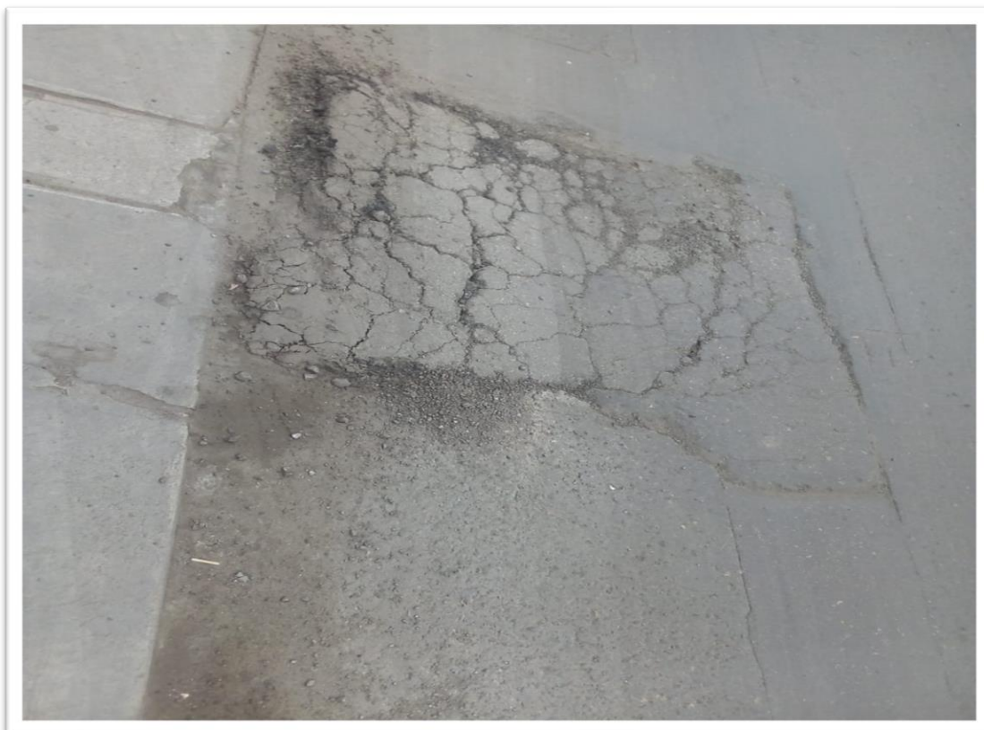
FALLA GRIETA DE BORDE (Nivel de severidad Intermedio)
