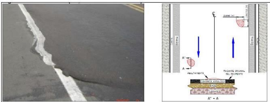
FIGURA N° H: Abultamientos (AB, unidad de medida, m 2 ) FUENTE: Manual para la inspección visual de pavimento flexible (2006). Instituto nacional de vías. Ministerio de Transportes de Colombia.
