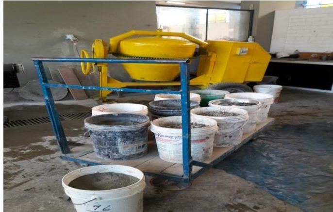
Figura 24. Insumos para preparación de concreto.
