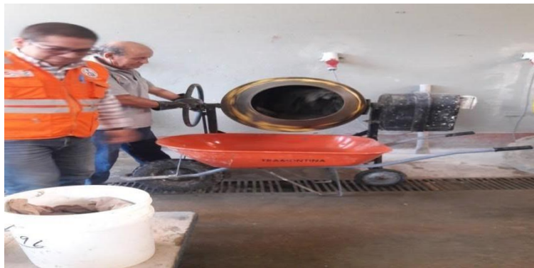
Figura 13. Preparación de mezcla de concreto.
