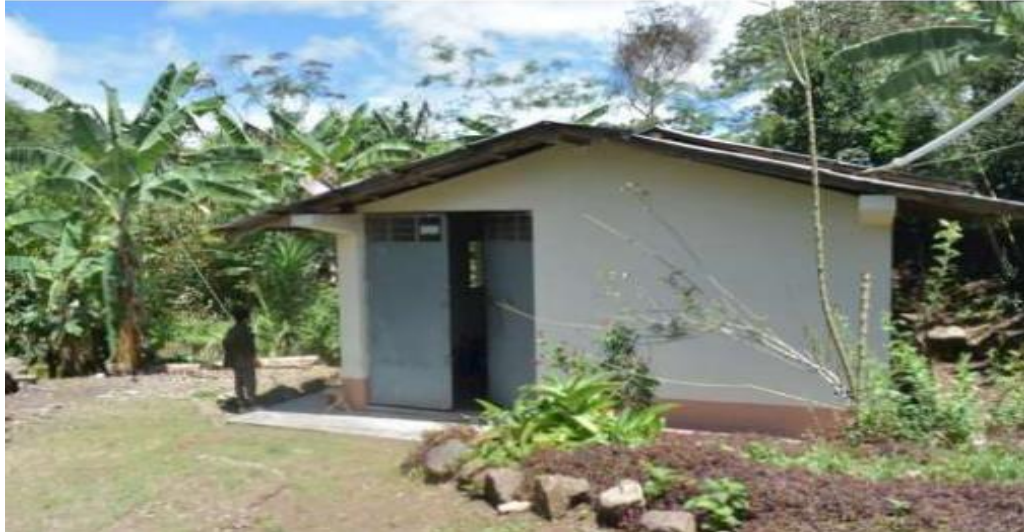
Figura 2. Vista de Mini-Central hidroeléctrica de Huarandoza
