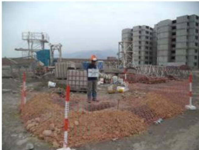
Figura 23. Calicata CE-24, se aprecia material extraído de la excavación
