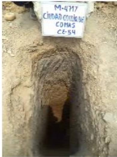
Figura 22. Vista interior de la calicata CE-54
