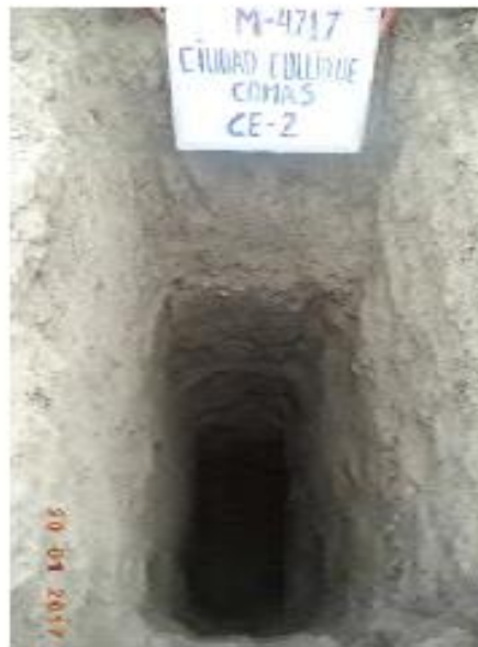
Figura 21. Vista interior de la calicata CE-2
