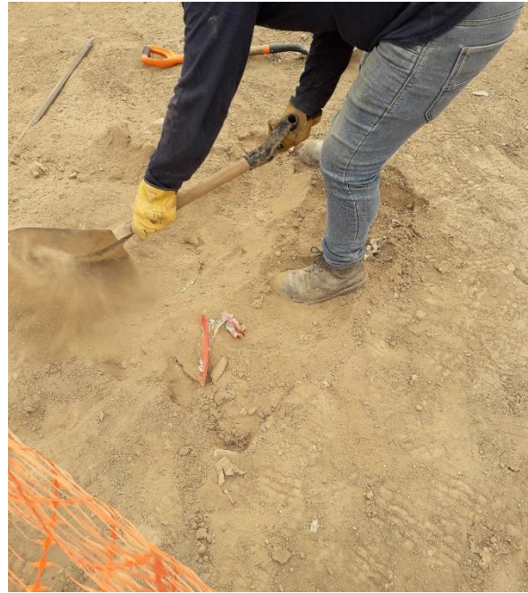
Fotografía 4. Inicio del retiro de la primera capa de superficial.
