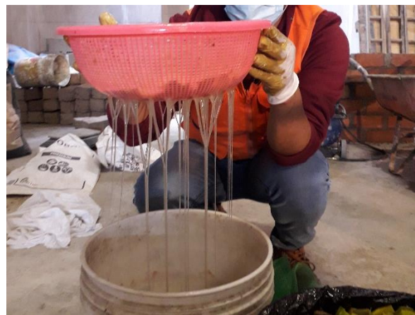
Fotografía 106. Vista del mucilago siendo colado.
