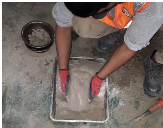
Fotografía 133. Mezcla de ambos materiales.
