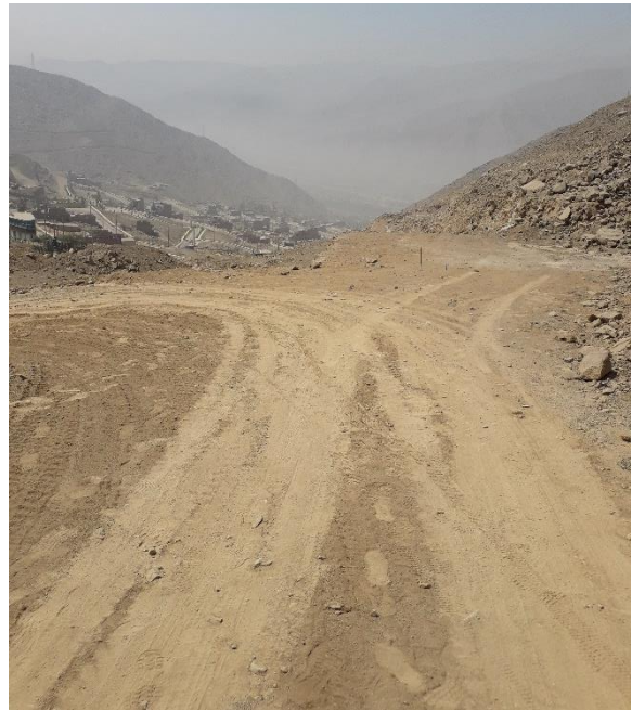
Fotografía 2. Acceso Huancarqui en dirección hacia el distrito de Huancarqui.
