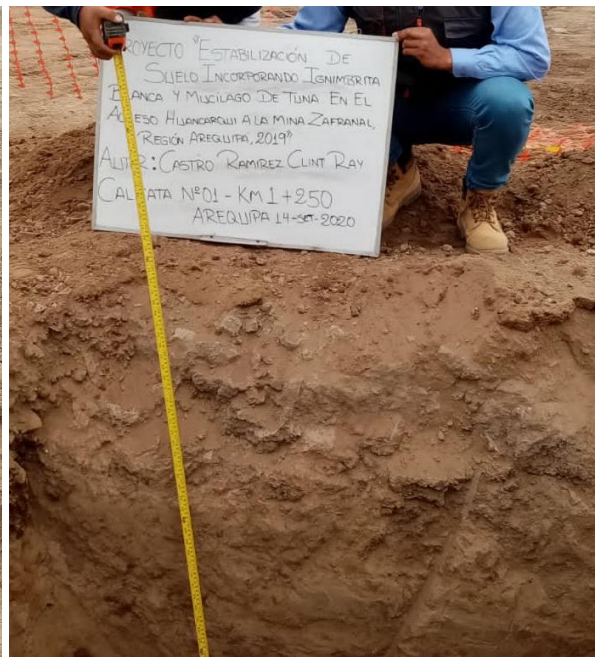
Fotografía 12. Calicata en el acceso Huancarqui- Km 1+250.
