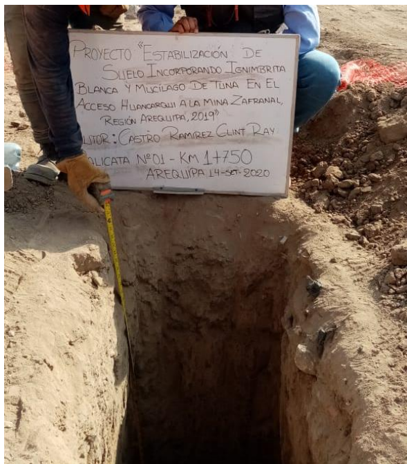
Fotografía 15. Calicata en el acceso Huancarqui- Km 1+750.
